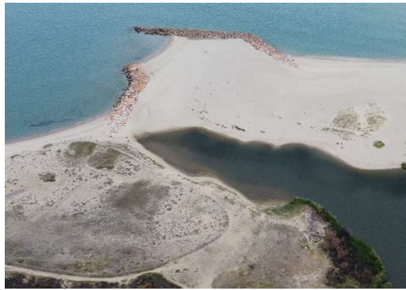
FIGURE 2 : PHOTO DU DEBOUCHE ILLUSTRANT L'IMPORTANT NIVEAU D'ENSABLEMENT DU DEBOUCHE (CASAGEC 2023)
