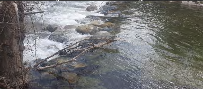
Seuil non recensé situé 10m à l'amont du pont faisant obstacle à la continuité piscicole . Justification du seuil : aménagement d'une zone de baignade.
