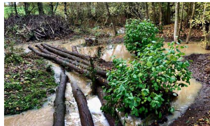
Exemple fixation d'embâcles (Source : Antoine WEROCHOWSKI – Réseaux Rivières)
