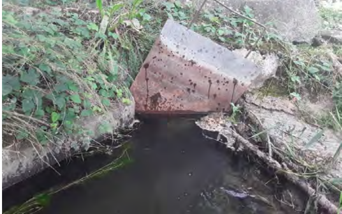
Vanne martelière non manipulable sur une prise d'eau en attente de régularisation (Ouvrage Seg#10)
