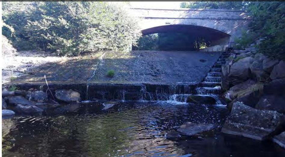
RAU-3 : Ouvrage infranchissable bétonné, avec passe à poisson dysfonctionnelle et prise d'eau à conserver
