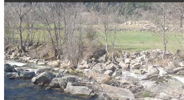
Protection de berge en rive droite liée à un terrain de pâturage et/ou fauchage entre Car-12 et Car-11
