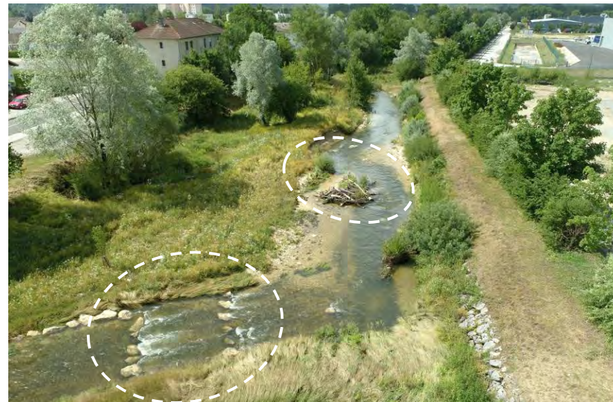
Exemple de création d'habitats additionnels et de diversification des faciès d'écoulement dans le Lange (SR3A, 01)
