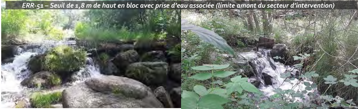
ERR-51 – Seuil de 1,8 m de haut en bloc avec prise d'eau associée (limite amont du secteur d'intervention)
