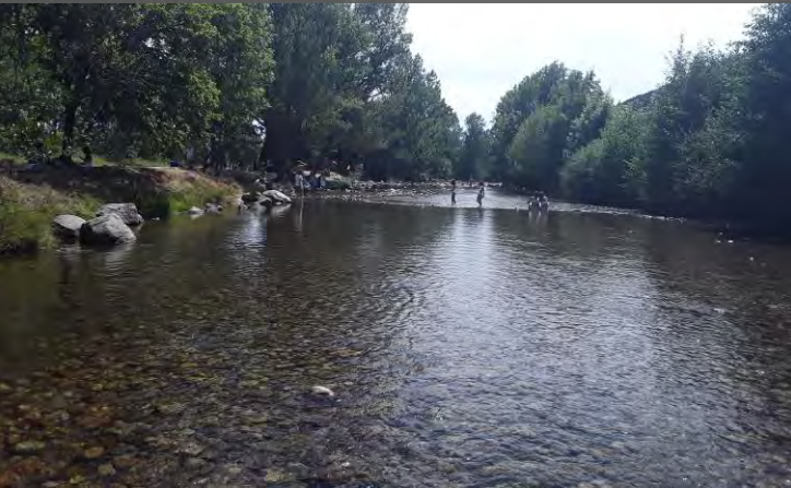
Tronçon rectifié et recalibré du Sègre dans sa traversée de la plaine : Uniformité du faciès d'écoulement et potentiel effet de réchauffement sur les secteurs non ombragé en période d'été.
