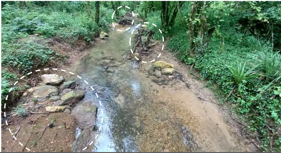
Exemple de renaturation du lit mineur par la création de banquette, de fixation d'embâcles et de poses de blocs sur l'Oiselon (SR3A, 01)
