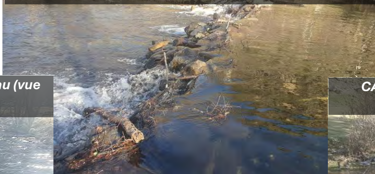
CAR-26 : Seuil infranchissable associé à un usage d'abreuvement
