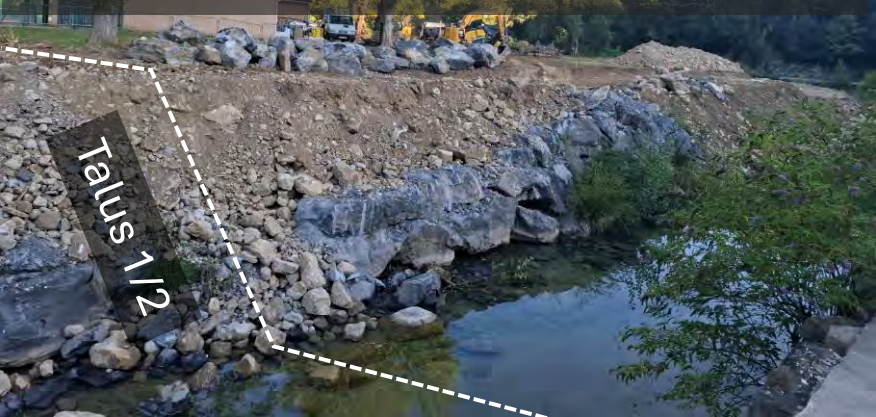
Démantèlement d'enrochement en cours avec conservation d'un talus de berge raide pour favoriser la reprise des matériaux (Travaux sur la Sals (11)- Opale, 2024)
