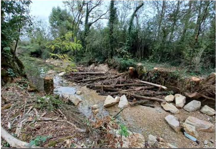
Exemple de renaturation du lit mineur par la création de banquette, de fixation d'embâcles et de poses de blocs sur l'Oiselon (SR3A, 01)
