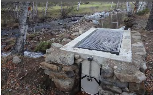
Exemple travaux de modernisation des prises d'eau réalisés sur la CCPC – De gauche à droite : Le Carol à Porté-Puymorens, le Rec de la Place à Err et le Rec de Via à Font-Romeu
