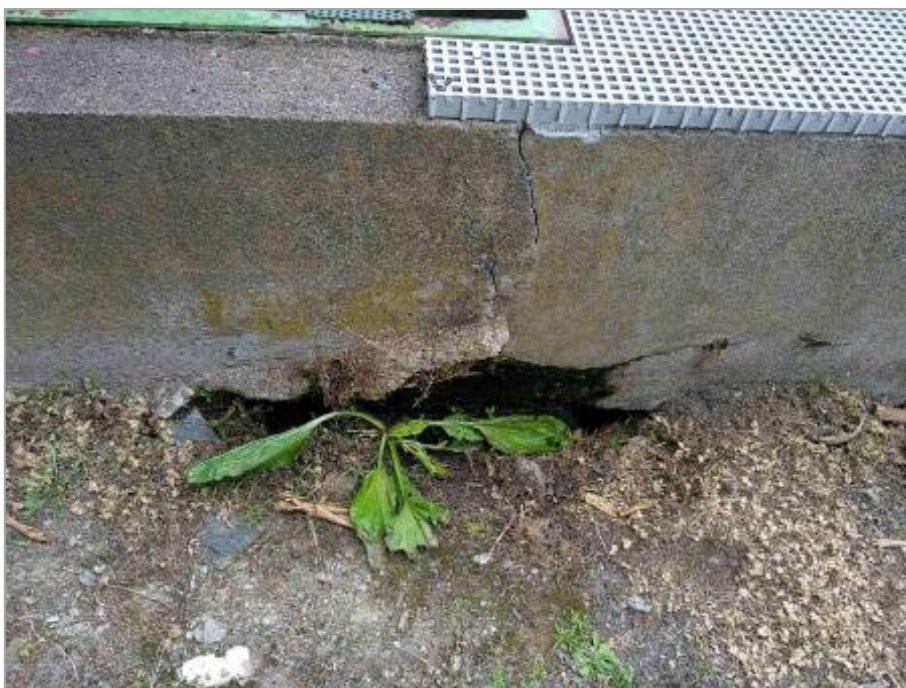
Creusement de la base de la maçonnerie du dégrilleur
