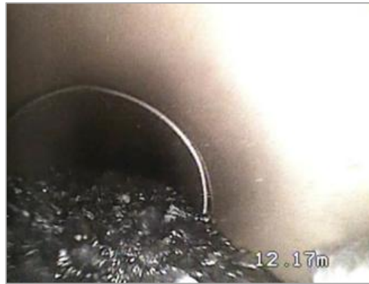
Branchement pénétrant - Rg2947a vers Rg2947b
