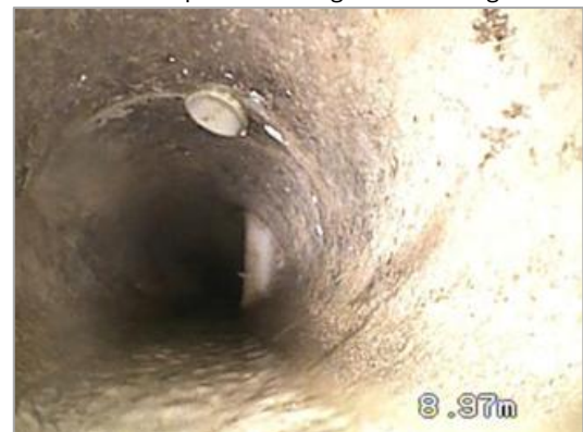
Branchement pénétrant - Rg2947a vers Rg2947b
