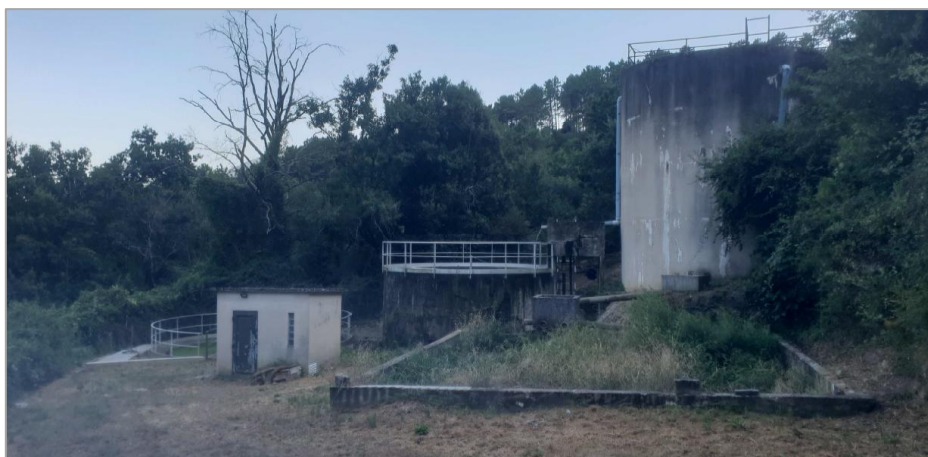
Figure 31 - Vue de la station d'épuration de Venaco
