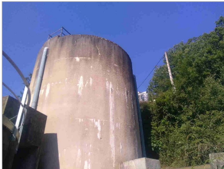
Décanteur-digesteur
