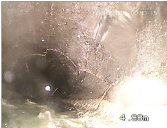
Usure de surface - Rg2716 vers Rg2717
