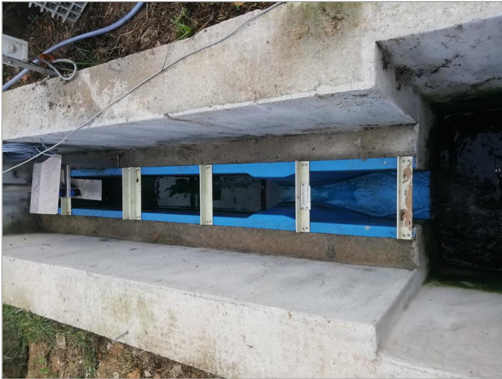
Canal Venturi en sortie station
