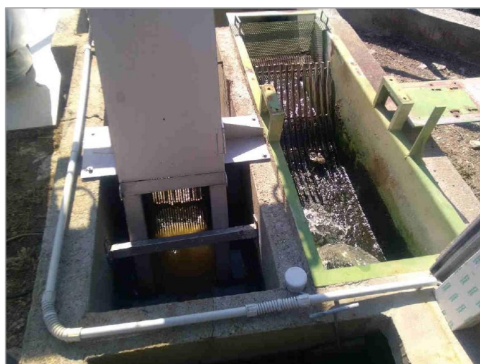
Déversoir d'orage en tête de station
