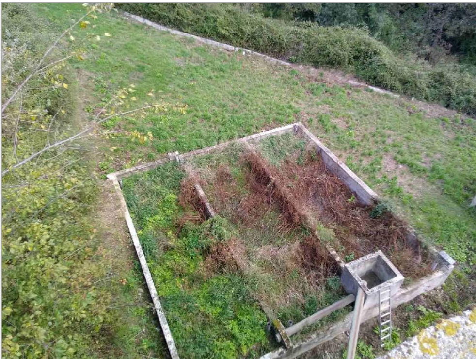
Lits de séchage des boues et des flottants
