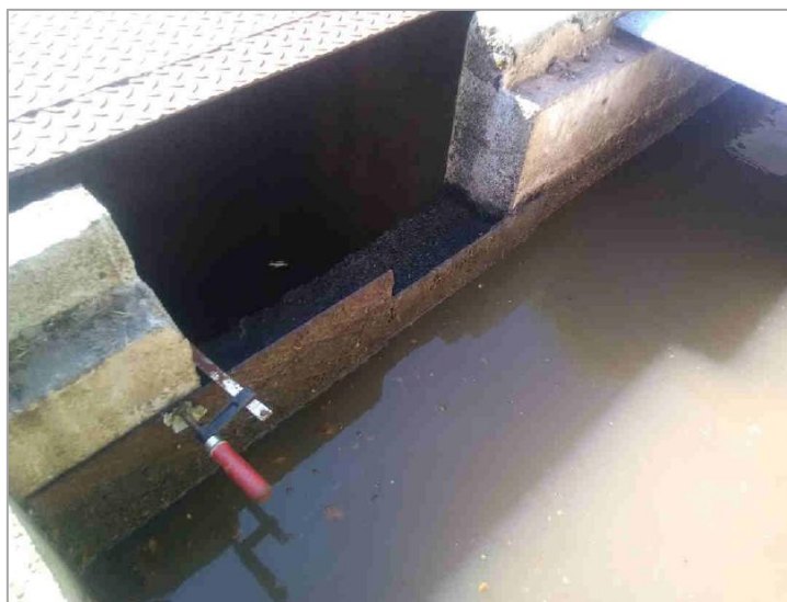
Déversoir d'orage en tête de station
