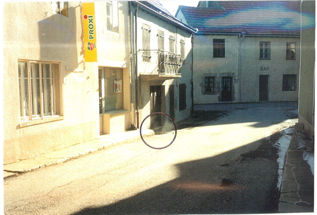
Photo 4, réseau non étanche la grille fume
