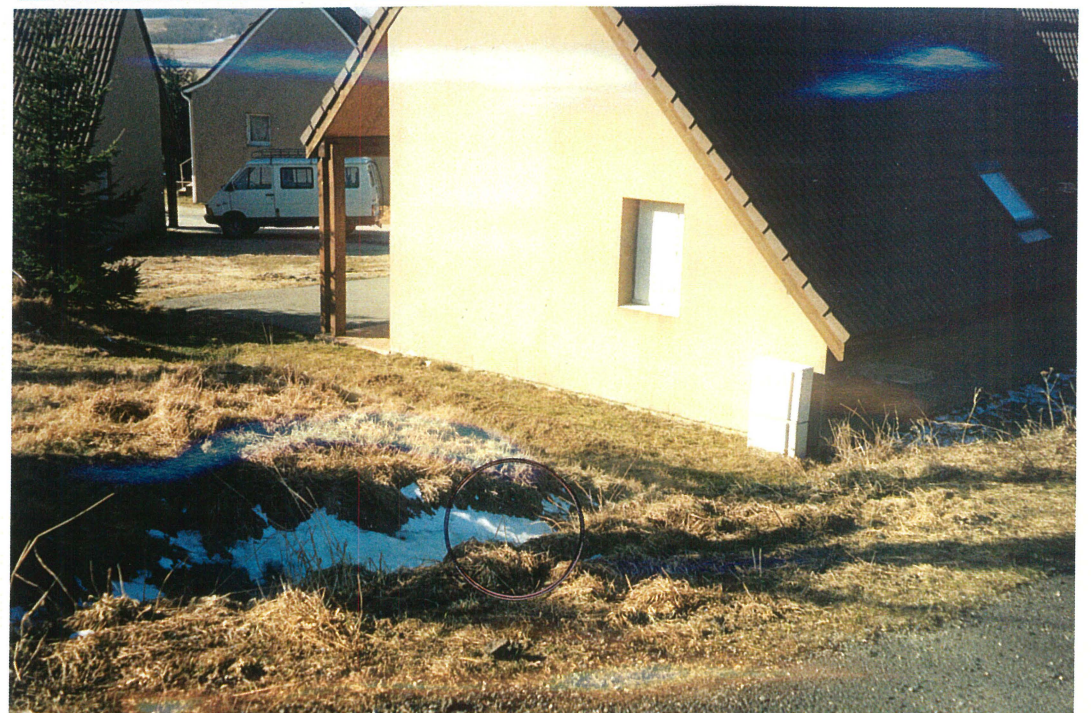
Photo 6, fumée sortant du sol
