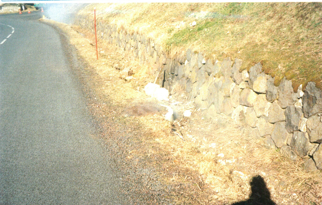
Photo 11, regard de visite non étanche
