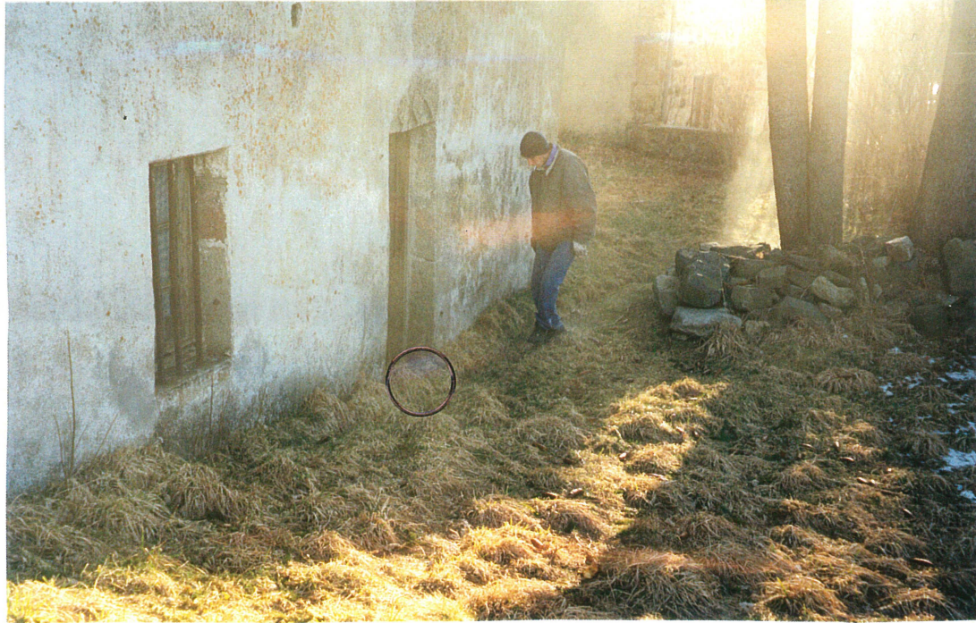
Photo 1, fumée sortant du sol
