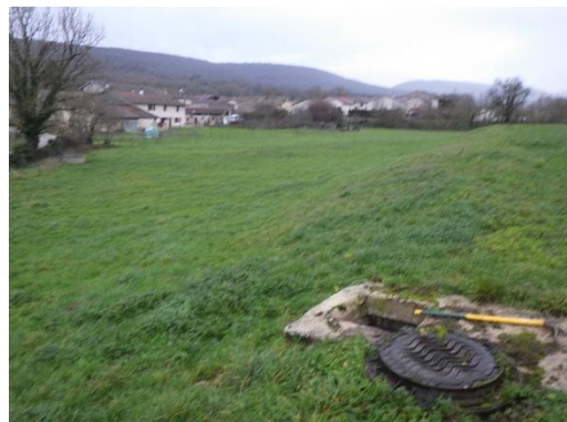
DO 4 – Vue extérieure – Cadre non scellé
