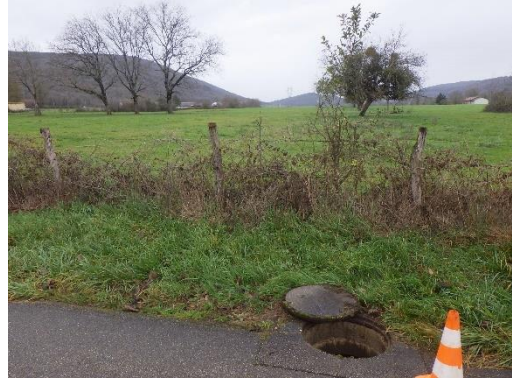
DO 1 – Vue extérieure
