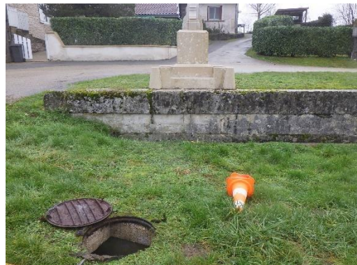
DO 2 – Vue extérieure
