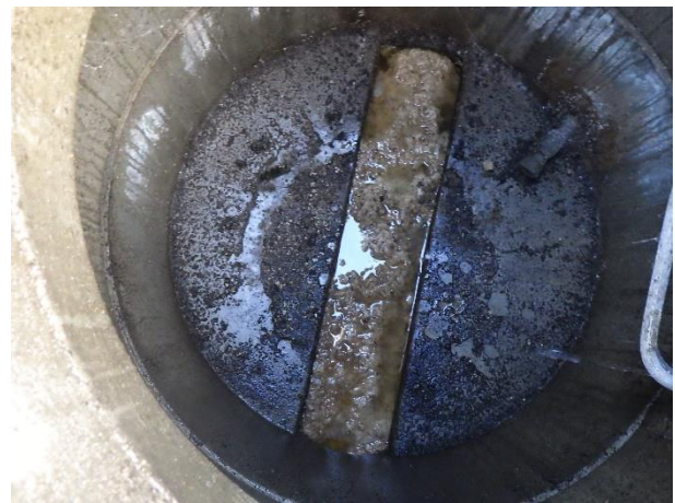
Dépôts et stagnation des effluents – Chavissiat-le-Grand – ID 25
