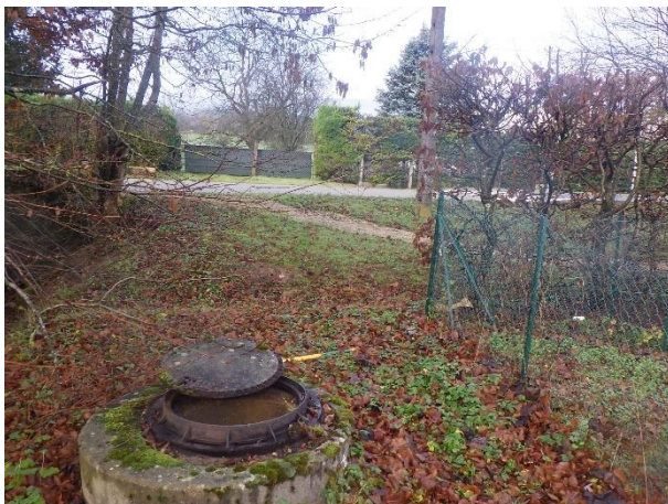
Cadre non scellé – D42 en direction de Corcelles – ID 266
