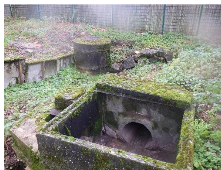
DO 2 – Vue extérieure
