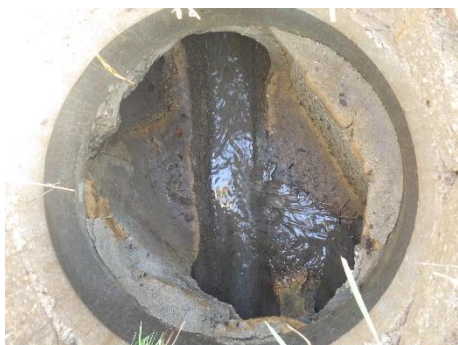
DO 128A – Vue intérieure
