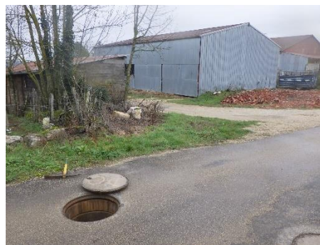
DO 5 – Vue extérieure
