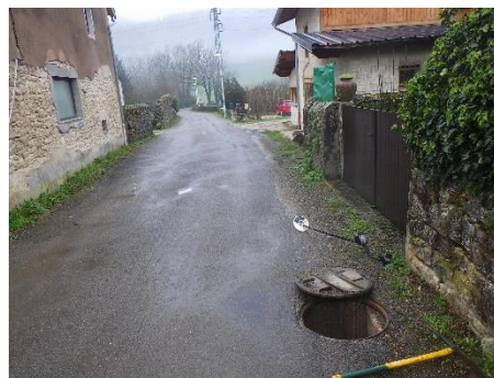
DO 1 – Vue extérieure
