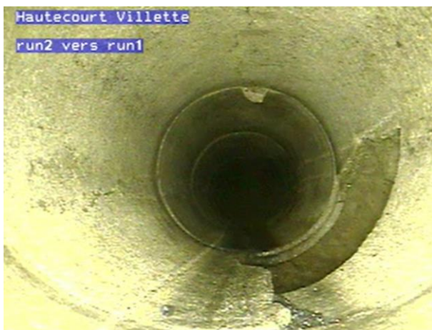
Casse sur le réseau (remplacé en 2021) – Entrée station Villette
