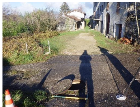
DO 6 – Vue extérieure
