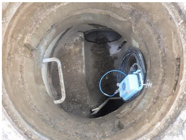
Suivi des déversements du DO réseau de Romanèche
