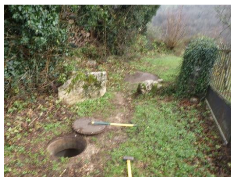
DO 4 – Vue extérieure
