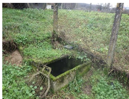
DO 3 – Vue extérieure
