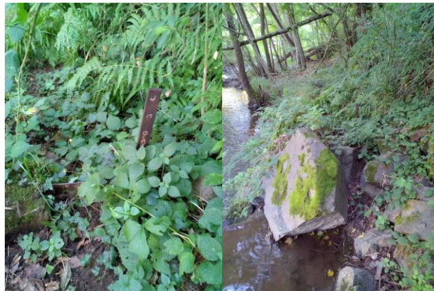
Figure 9: Bief bouché rive droite et pelle métallique
