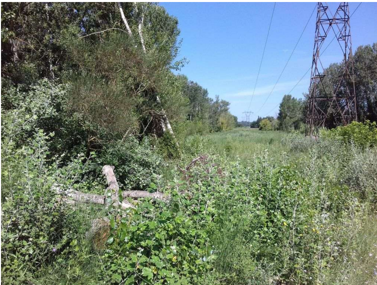
Figure 5 : Ligne à Haute Tension et entretien de la végétation adjacente
