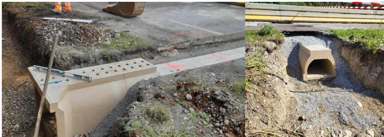
Figure 37 : Chantier du crapauduc de Vesancy en cours
