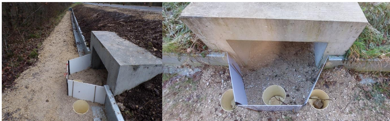
Figure 32 : Exemple de suivi par piégeage en sortie d'ouvrage mis en œuvre dans l'Aube par le Parc naturel régional de la Forêt d'Orient. Une trappe en béton incluse dès la conception et correspondant à la largeur de l'ouvrage sera préférée afin d'éviter les demi-tour d'amphibiens ©PNR Forêt d'Orient
