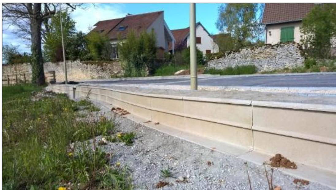
Figure 28 : Barrière de guidage optimale de type ACO LEP100 équipée d'un double surplomb pour empêcher le franchissement des espèces grimpeuses (rainettes, grenouilles, etc.)
