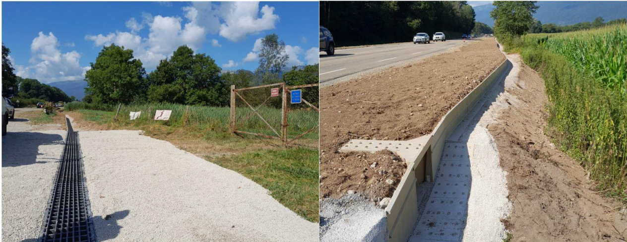
Figure 38 : Crapauduc de Vesancy finalisé
