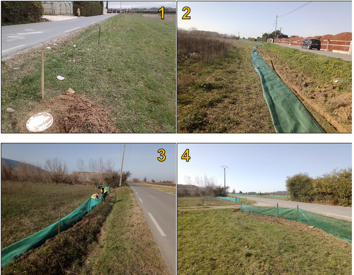
Figure 2 : Chantier d'installation du crapauduc. Photo 1 : mise en place des seaux et des piquets. Photo 2 : préparation de la tranchée et du filet. Photo 3 : fixation du filet sur les piquets. Photo 4 : section de crapauduc finalisée
