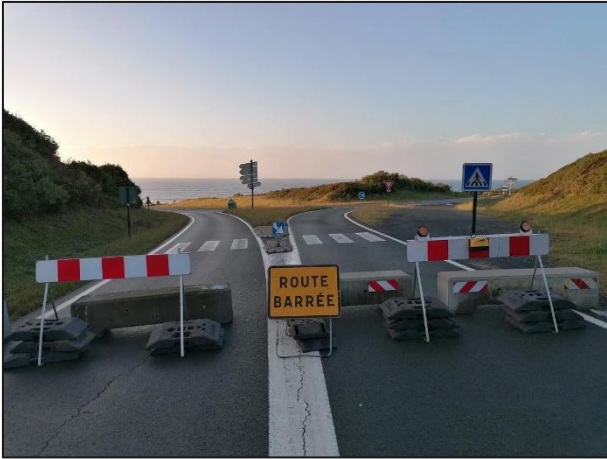
Figure 40 : Fermeture avec blocs bétons empêchant le passage des véhicules © Crédit photo : Archives Vincent Dewitte
