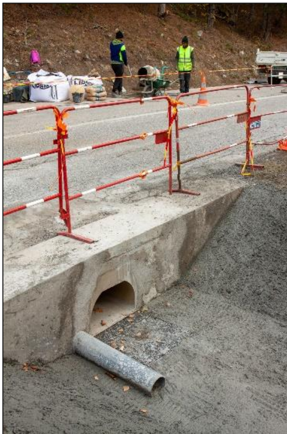
Figure 35 : Installation d'un aqueduc dans l'ouvrage Source : V. VIRIEVE – AGIR écologique
