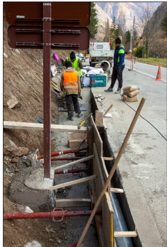
Figure 36 : Installation d'un aqueduc dans l'ouvrage Source : V. VIRIEVE – AGIR écologique
