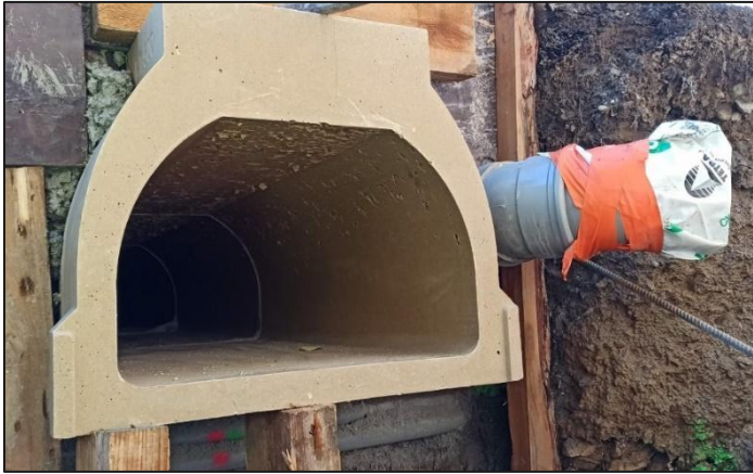
Figure 33 : Installation du Crapauduc avant coffrage béton Source : P. CHEVALIER, Métropole Nice Côte d'Azur
