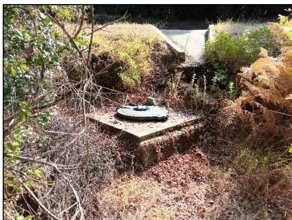
Photo 14 : Regard brise charge sur le réseau d'adduction des sources de FUNTANA (TPAe, 11/08/2022)
