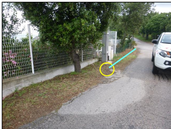
Photo 134 : Vanne d'arrêt (vidange sans exutoire) en bout du réseau de ZIZOLI
