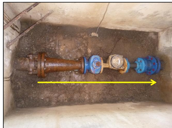
Photo 19 : Compteur n°18 (point de vente d'eau à 3 bâtiments privés par la commune de GROSSETO PRUGNA), vanne de sectionnement non accessible de l'autre côté de la route
