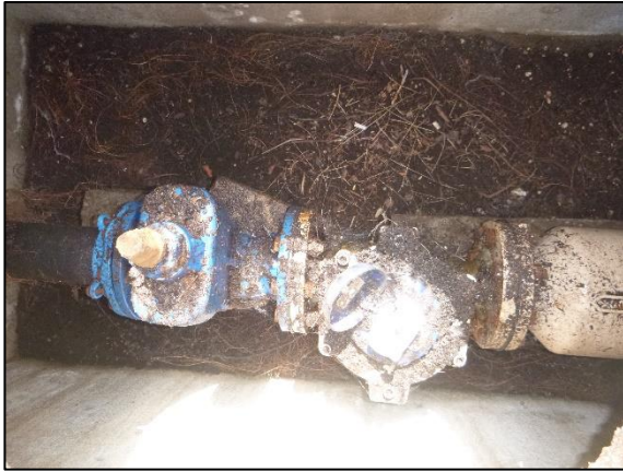
Photo 12 : Compteur sur DN100 (rôle à clarifier, OEHC)
