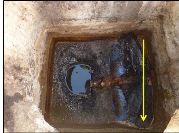
Photo 34 : Passage de conduite Fonte 150 (commune de GROSSETO PRUGNA)
