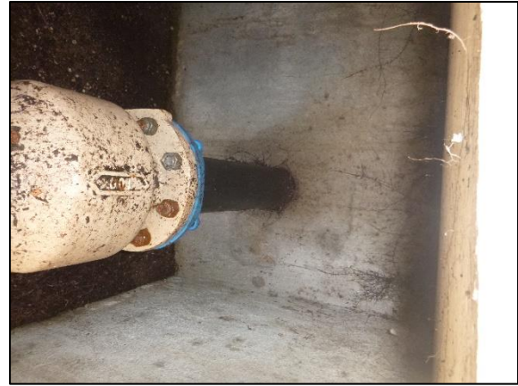
Photo 12 : Compteur sur DN100 (rôle à clarifier, OEHC)
