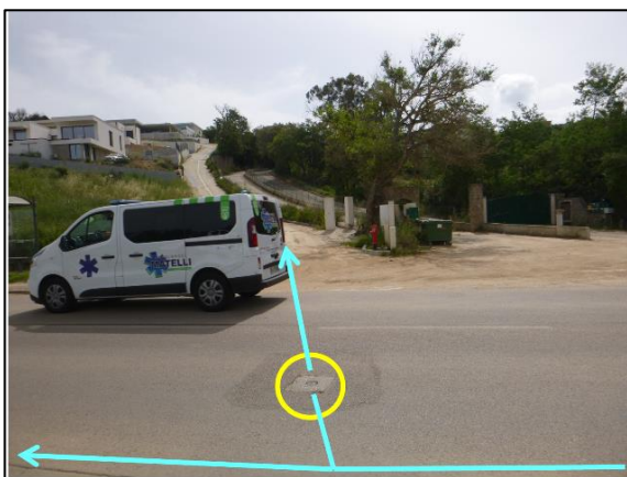
Photo 7 : Vanne communale vers résidence privée
