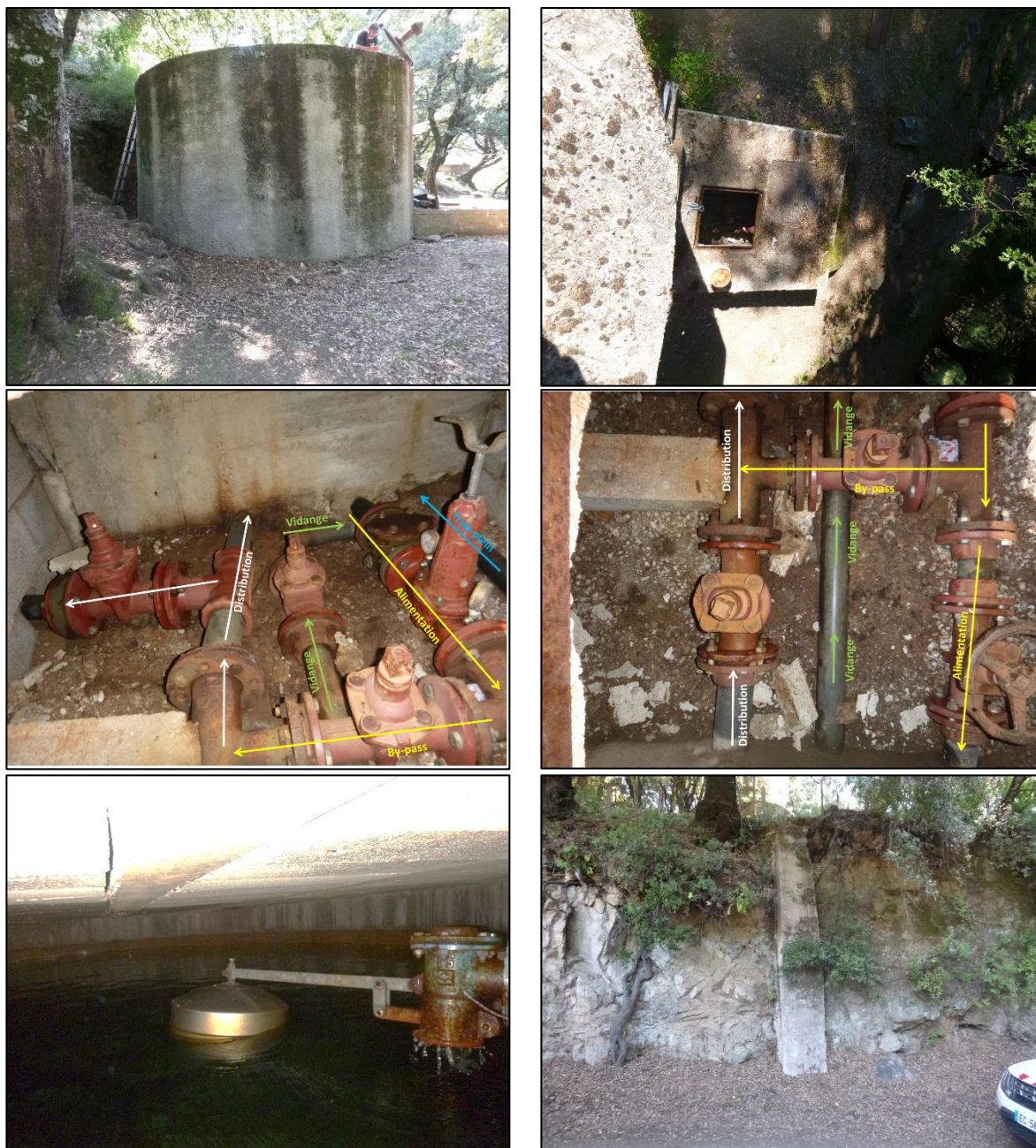
Photo 25 : Réservoir de PRUGNA (TPAe, 23/06/2022)
