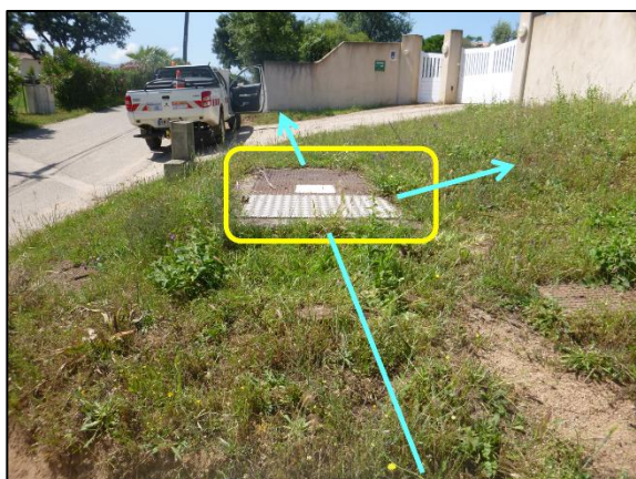
Photo 70 : Compteur n°52 DN40 (point de vente d'eau à PEIRETTI par la commune de GROSSETO PRUGNA), fin du réseau communal
