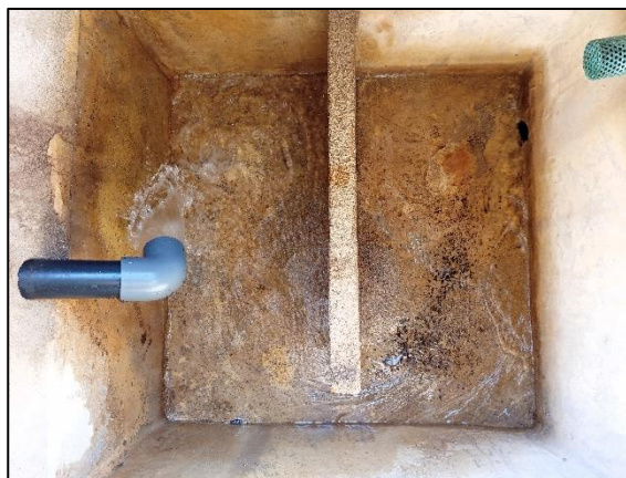
Photo 14 : Regard brise charge sur le réseau d'adduction des sources de FUNTANA (TPAe, 11/08/2022)
