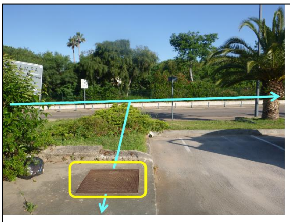
Photo 19 : Compteur n°18 (point de vente d'eau à 3 bâtiments privés par la commune de GROSSETO PRUGNA), vanne de sectionnement non accessible de l'autre côté de la route
