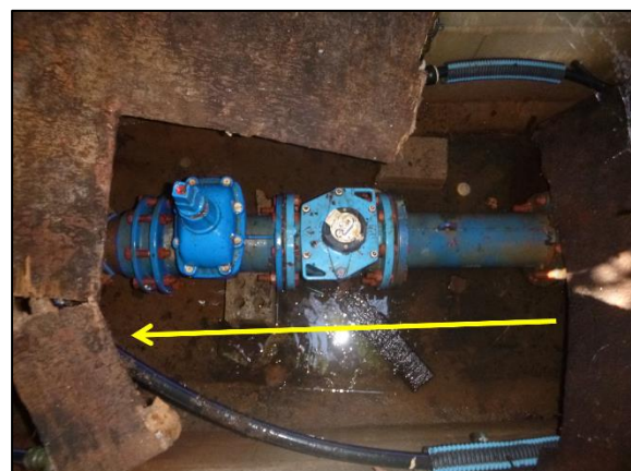
Photo 83 : Compteur n°66 (commune de GROSSETO PRUGNA), vanne en sortie de résidence
