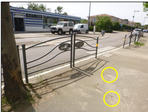
Photo 17 : Vannes communales vers Résidence (un compteur en aval de chaque vanne)
