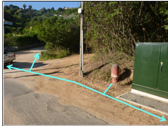
Photo 85 : Poteau incendie et vanne non trouvée sur l'antenne à droite (commune de GROSSETO PRUGNA), route des CANNES
