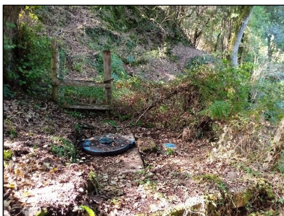
Photo 6 : Regard de décantation de la source de PIAZELLI (TPAe, 11/08/2022)
