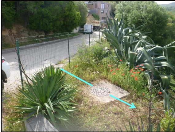
Photo 101 : Compteur n°77 su PEHD DN32 (point de vente d'eau à CASA D'ORU par la commune de GROSSETO PRUGNA)
