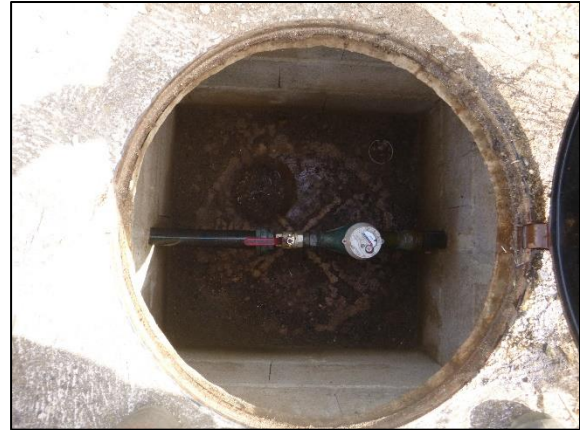
Photo 101 : Compteur n°77 su PEHD DN32 (point de vente d'eau à CASA D'ORU par la commune de GROSSETO PRUGNA)
