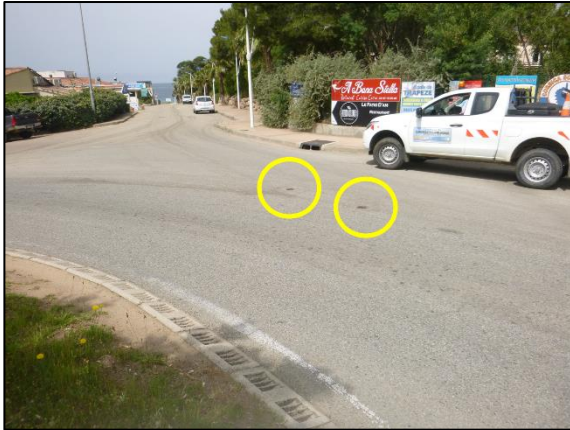
Photo 20 : Vannes communales de sectionnement vers mairie et plage
