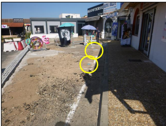
Photo 22 : Vannes de sectionnement individuelles
