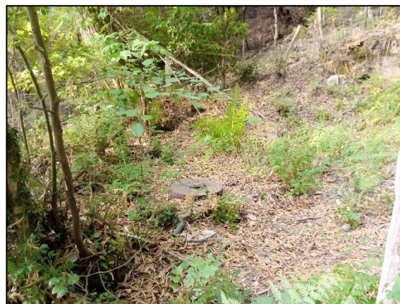
Photo 11 : Regard de captage (TPAe, 11/08/2022)
