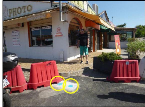
Photo 21 : Vannes de sectionnement individuelles
