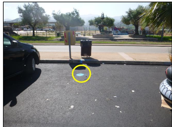
Photo 25 : Vanne de sectionnement
