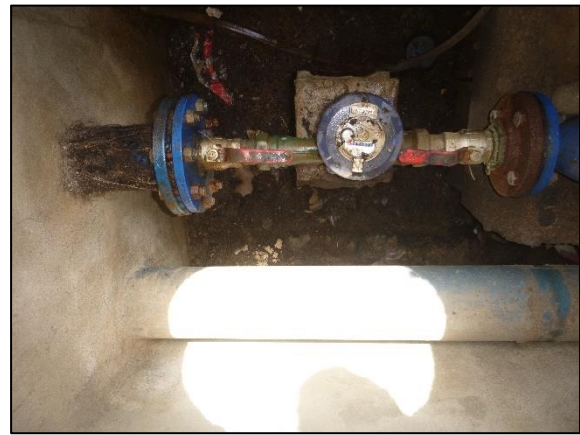
Photo 12 : Compteur sur DN100 (rôle à clarifier, OEHC)
