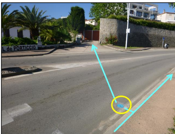
Photo 33 : Vanne de sectionnement 4 bâtiments (commune de GROSSETO PRUGNA)
