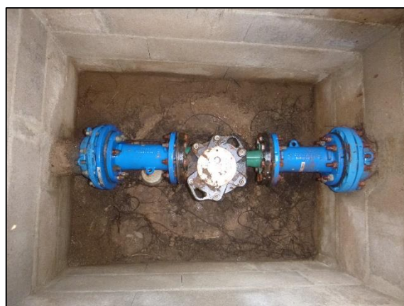
Photo 16 : Station de pompage et compteur de distribution
