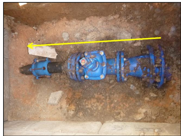
Photo 35 : Passage de conduite Fonte 150 → PVC 90 avec vanne de sectionnement (commune de GROSSETO PRUGNA)
