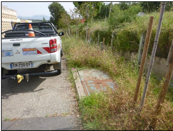
Photo 9 : Vanne communale sur antenne PEHD63
