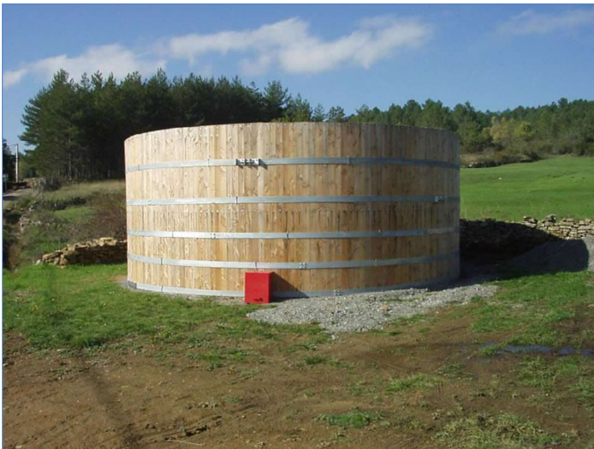
Photographie 3 : Exemple d'une cuve réservoir DFCI, exclusivement destinée à la Défense Incendie
