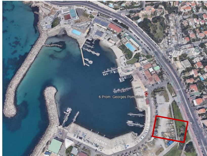
Photographie aérienne du site – Zone de travaux (Google earth ©)
