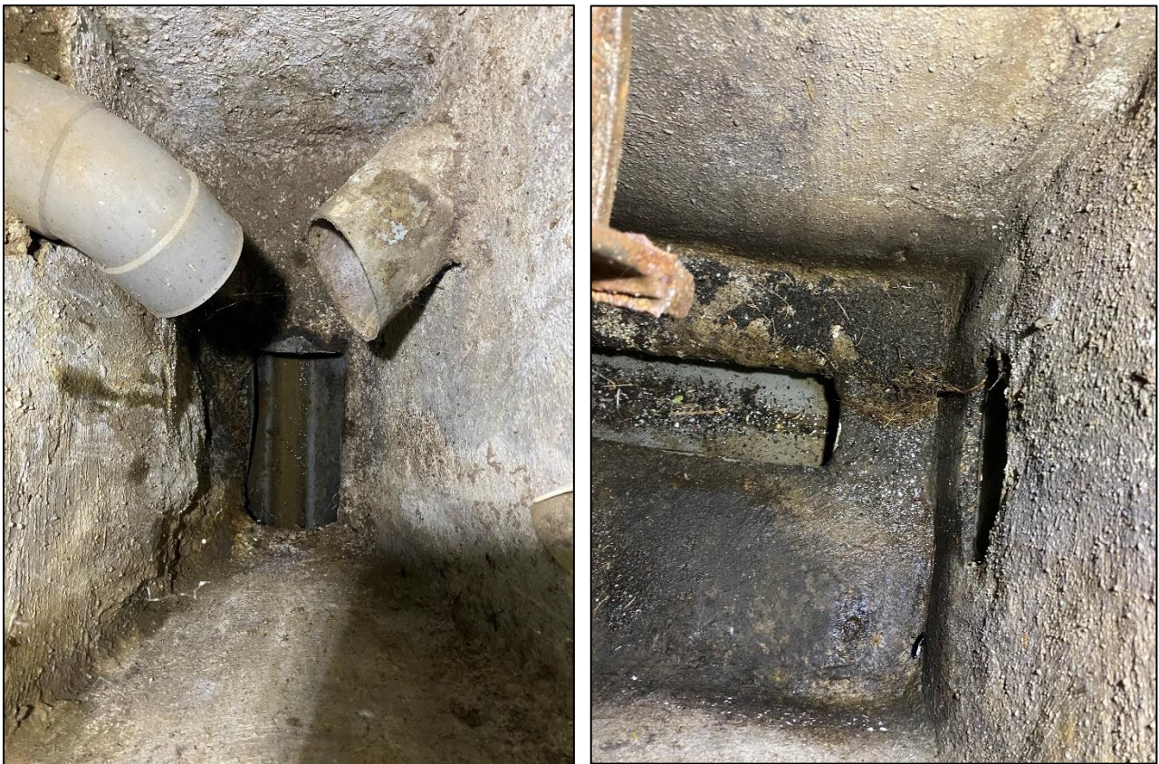
Figure 13 : Photographies de l'inspection nocturne des réseaux en juin 2021
