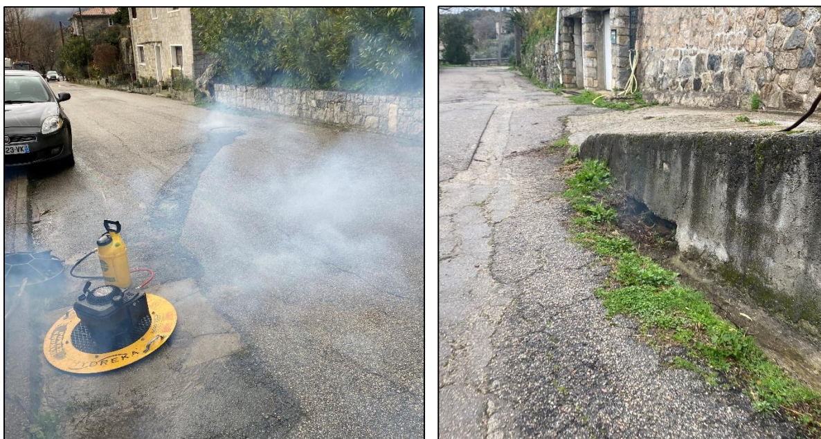
Figure 14 : Illustrations des tests à la fumée réalisées le 8 février 2021
