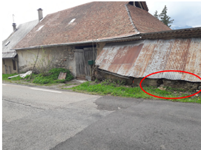
Figure 48 : Photographie de la bâtisse (ERG-02/05/2019)
