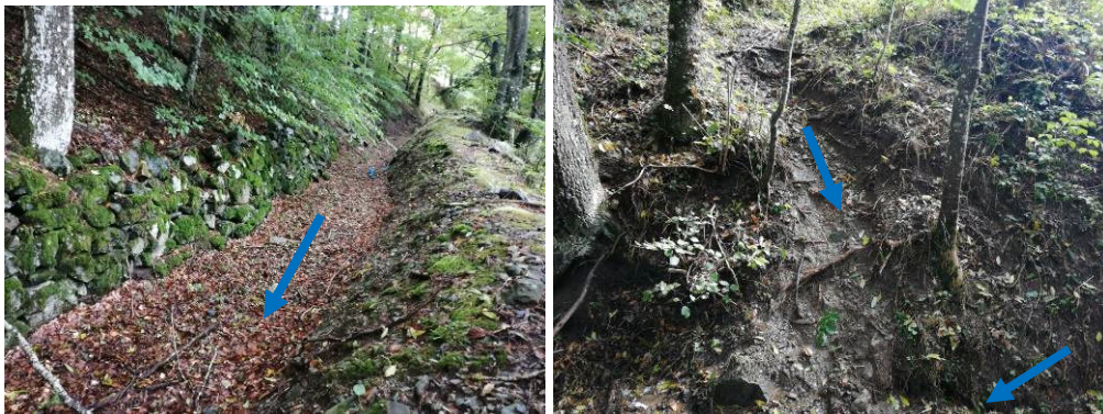
Figure 24 : Mur en pierre sèche et arrivée d'eau en RD
