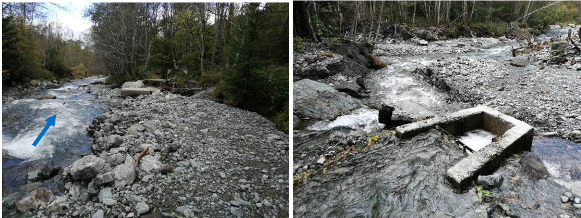
Figure 27 : Seuil et prise DN350 en acier
