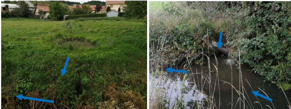
Figure 18 : Arrivée d'eau en RD
