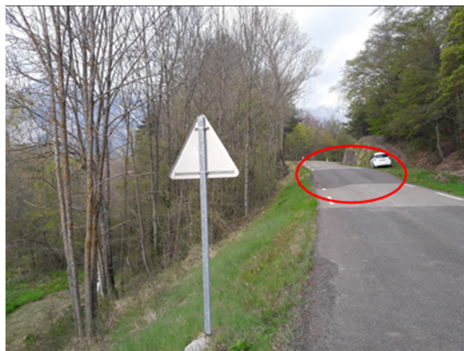
Figure 47 : Photographie illustrant l'affaissement (ERG-02/05/2019)
