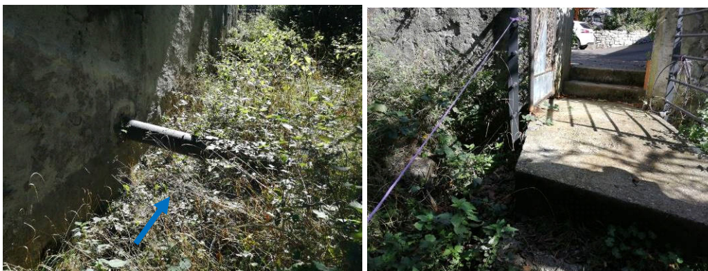
Figure 43 : Tuyau aérien et ponceau
