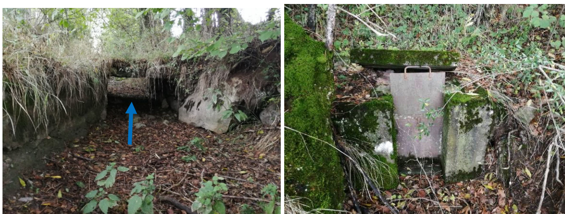
Figure 13 : Ponceau et prise
