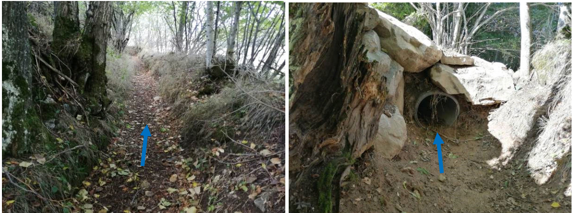
Figure 40 : Canal et buse PE DN600
