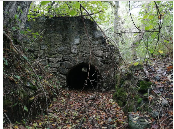
Figure 55 : Pont-Bâche du torrent des Courts au WP281
