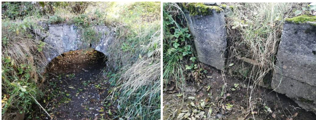
Figure 33 : Ponceau et prise
