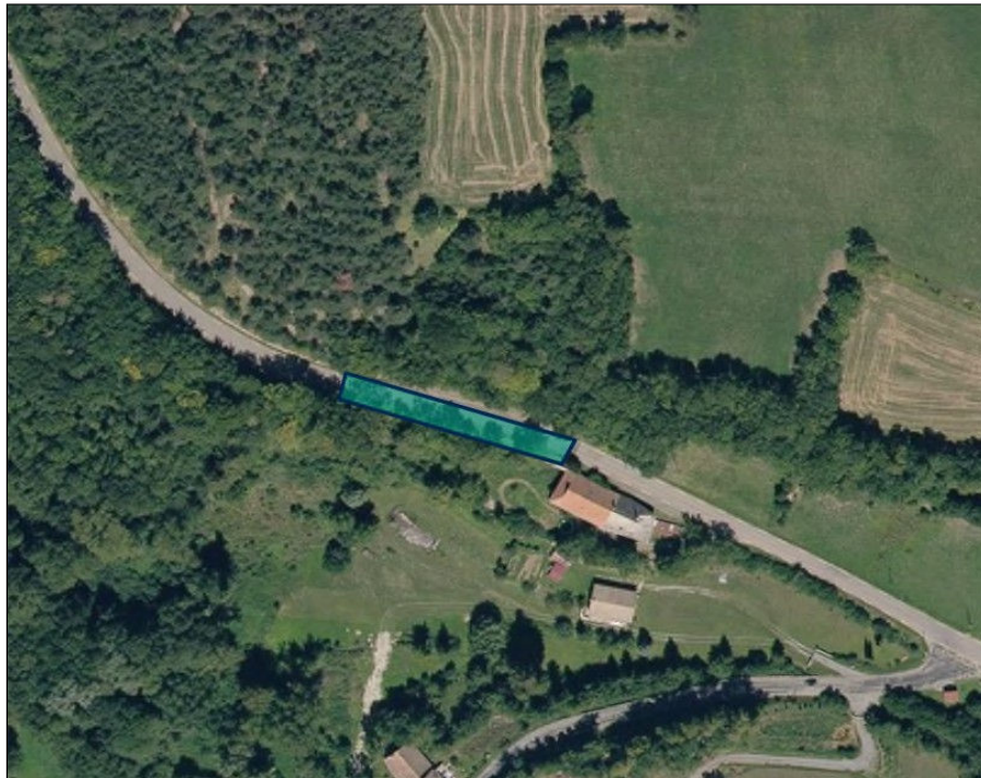
Figure 44 : Localisation de l'affaissement (géoportail.fr)
