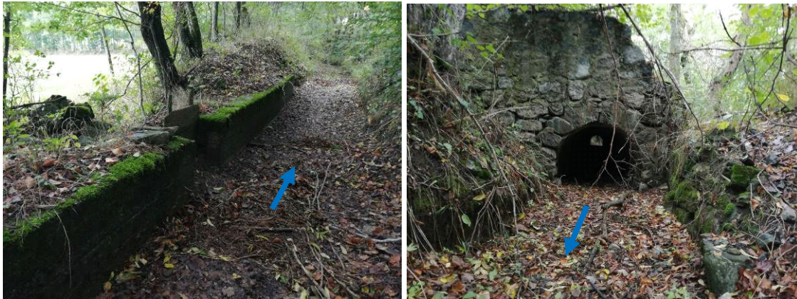
Figure 16 : Prise et muret en RG et sortie pont bâche
