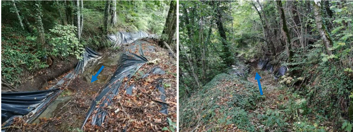
Figure 14 : Bâches sur glissement
