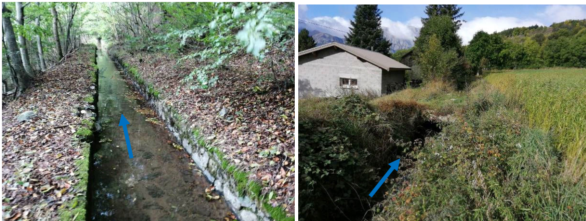
Figure 30 : Zone maçonnée et ponceau
