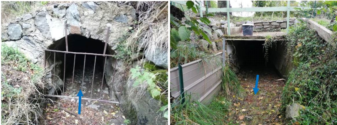
Figure 10 : Entrée et sortie galerie sous Le Serre
