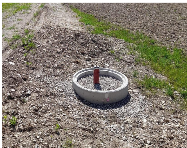
Figure 26 – Alternative à la borne : la prise individuelle « hydrant » avec vanne wright rain
