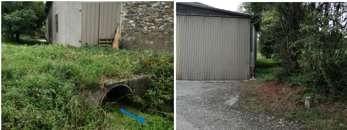
Figure 17 : Buse sous construction
