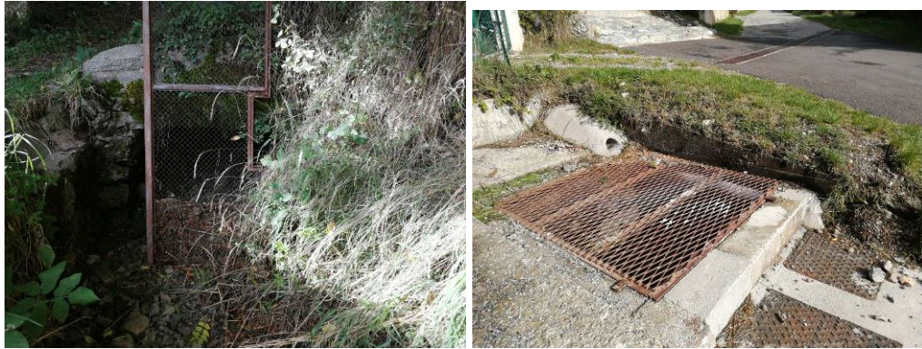
Figure 31 : Entrée voûte et regard grillagé au centre du village
