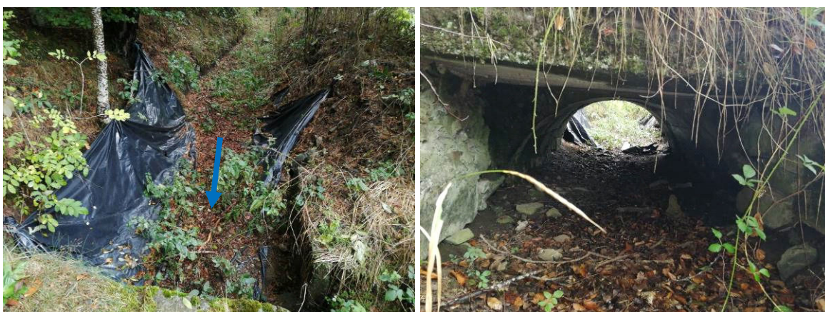
Figure 23 : Ponceau avec polyane
