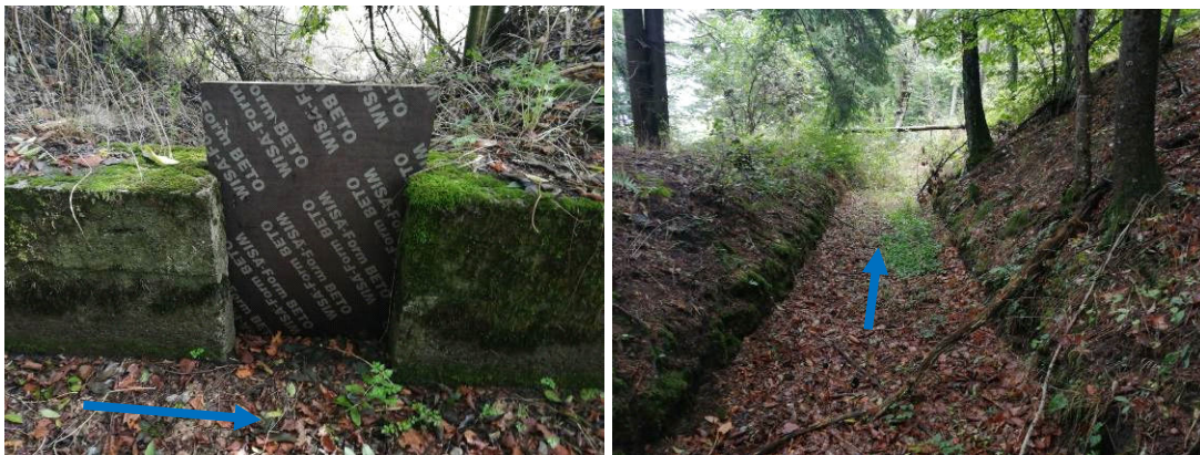
Figure 22 : Prise et canal vue vers l'amont
