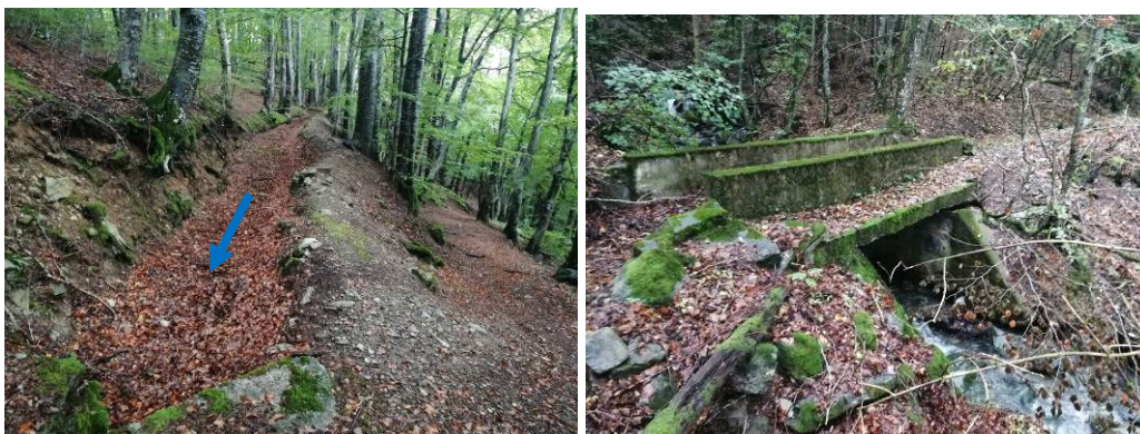
Figure 26 : Aval du canal
