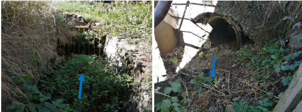
Figure 42 : entrée et sortie sous le Villardon
