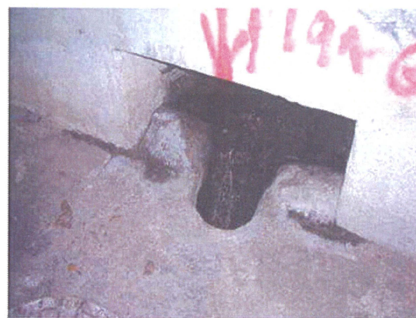
Exemple de déversoir d'orage installé sur une branche annexe au collecteur principal du Morgon
