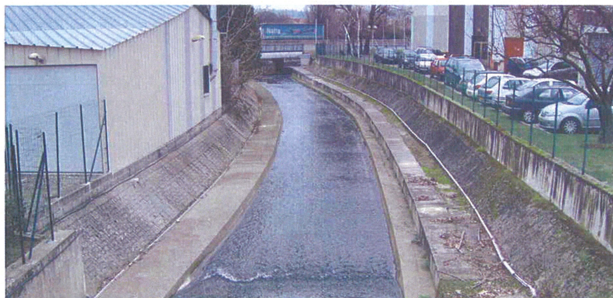
Le Morgon au droit du pont de la rue Alexandre Richetta
