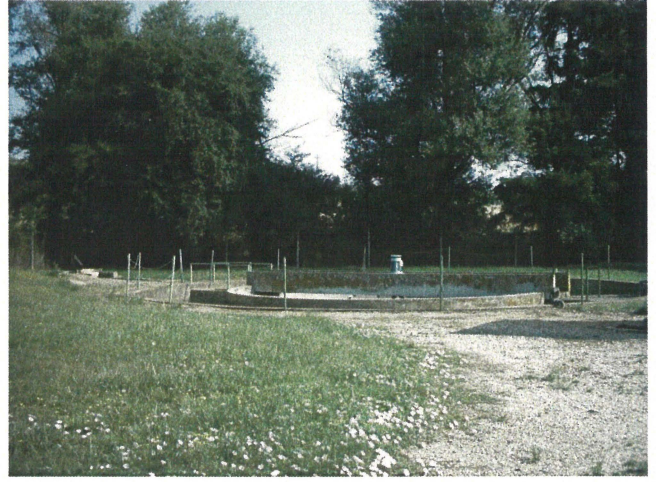
Photo 4: station d'épuration, et D.O. de la photo 3
