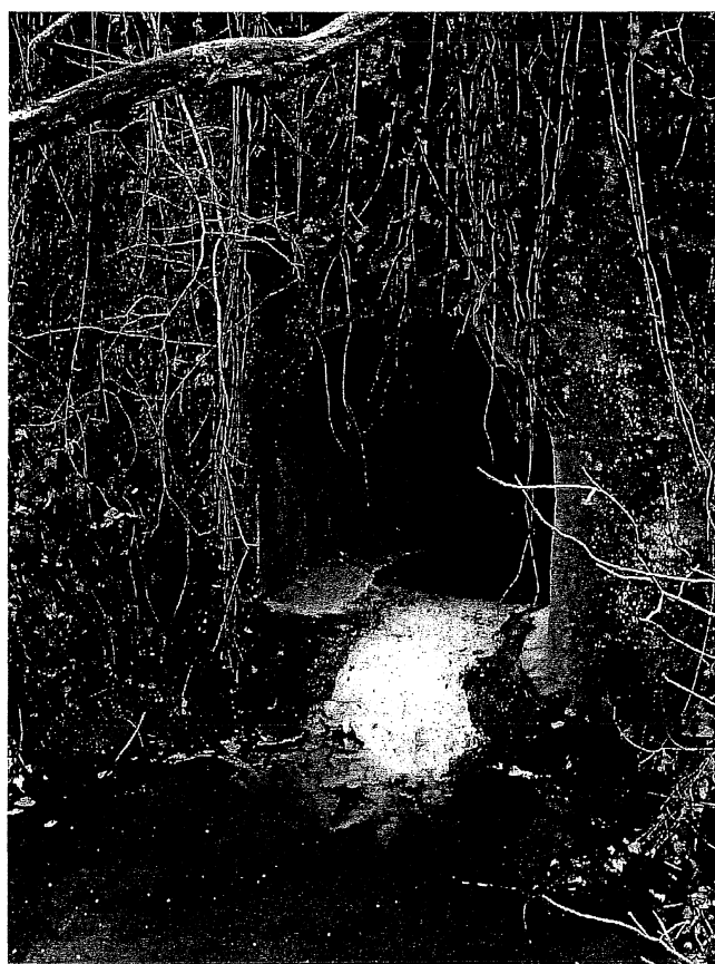
Aval de l'ouvrage situé sous la voie communale
