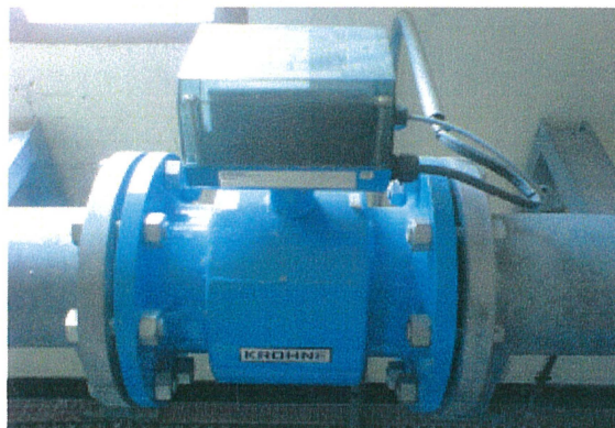
Manchette électromagnétique sur la canalisation de refoulement
