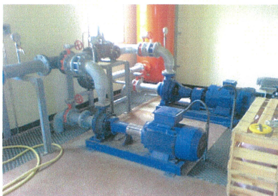
Manchette électromagnétique sur la canalisation de refoulement
