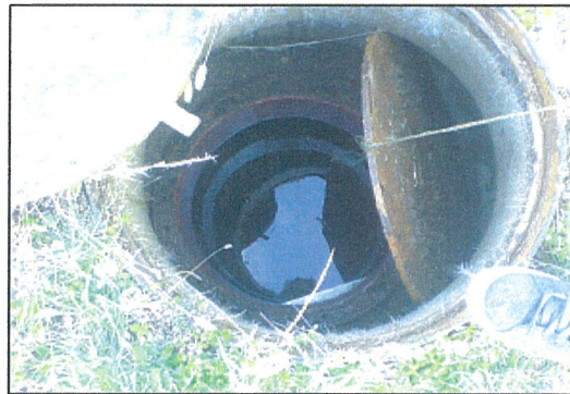
Vue de dessus de la bâche
