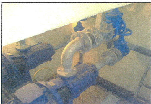
Compteur sur canalisation en aval des pompes
