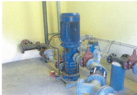
Canalisation de refoulement
