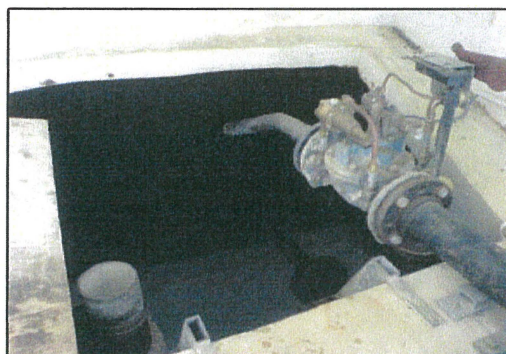
Canalisations trop plein et alimentation
