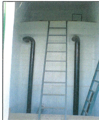
Canalisations alimentation et distribution
