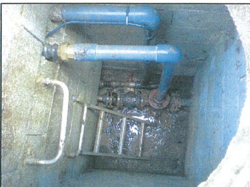
Canalisations alimentation et distribution
