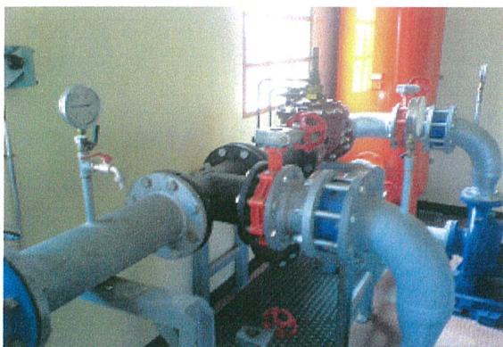
Canalisation de refoulement
