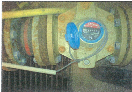
Compteur sur canalisation en aval des pompes
