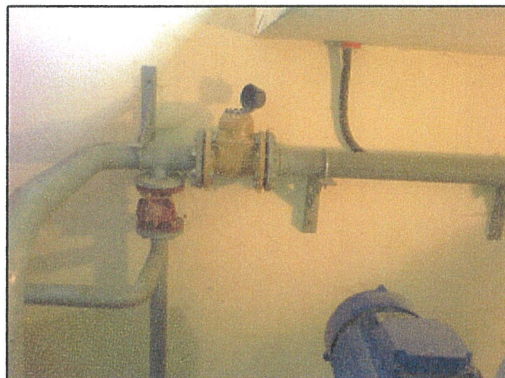
Compteur sur canalisation en aval des pompes
