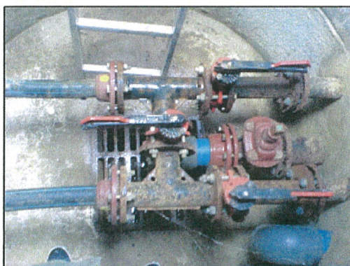
Canalisations alimentation et distribution
