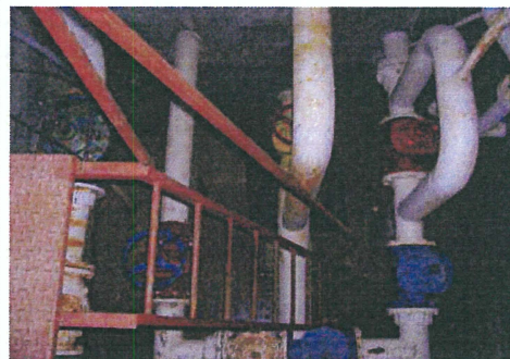
Chambre de vannes
