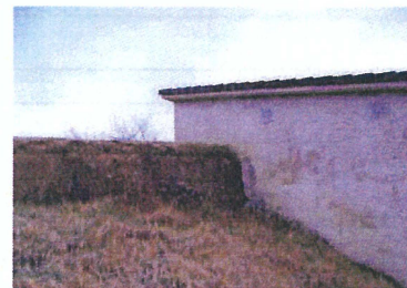
Projection béton pour stabiliser l'ouvrage
