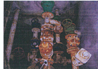
Chambre de vannes
