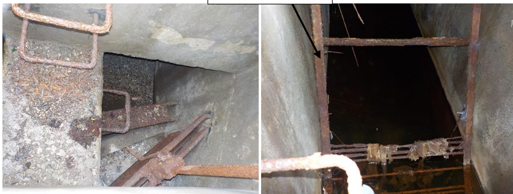
Figure 46 Photos de l'ouvrage désaffecté
