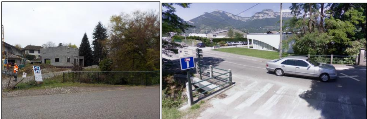
Figure 80 : Pont du Puits d'Ordet et construction en cours en avril 2022 (à gauche) et Pont Richelieu (à droite)
