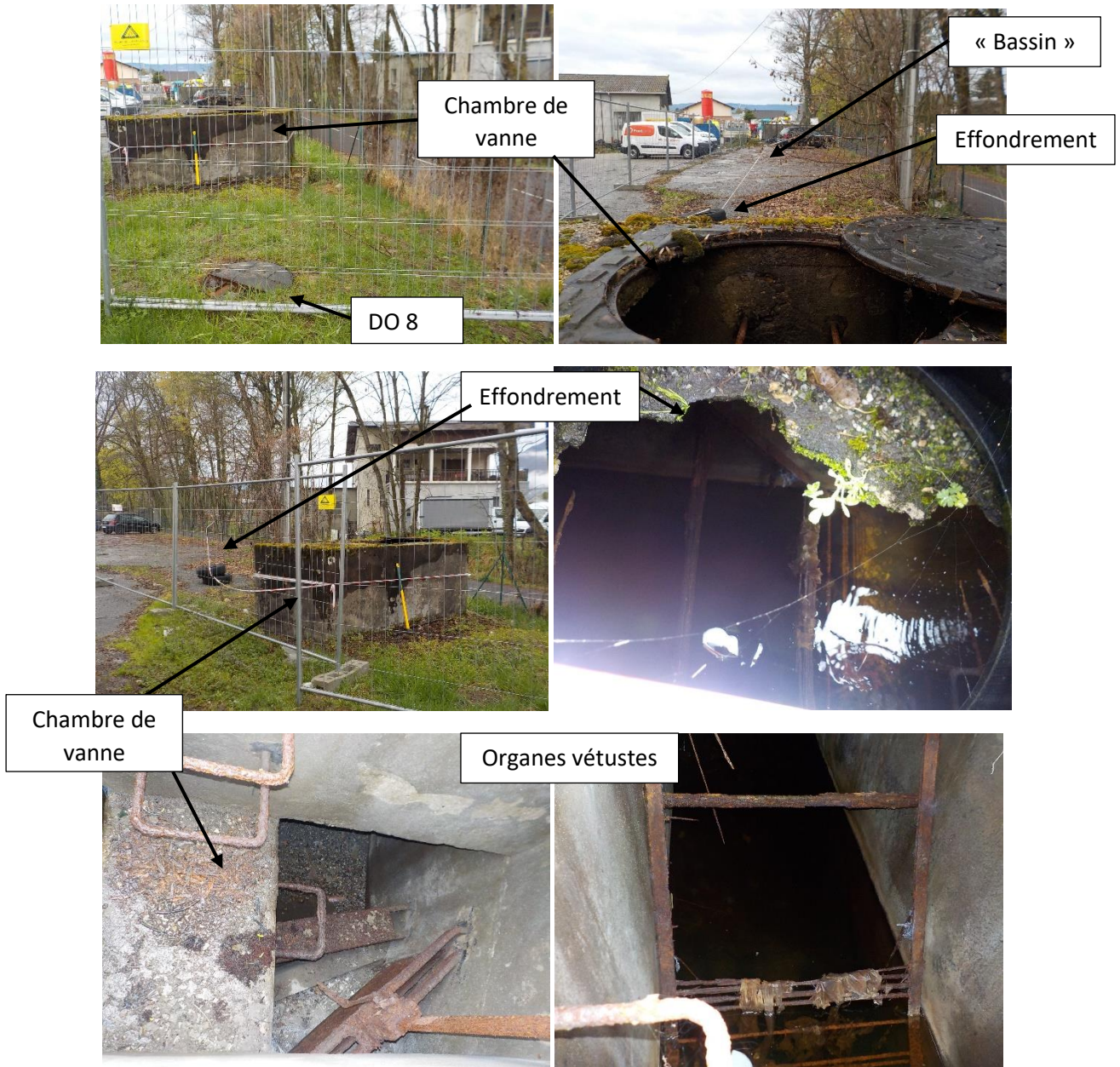
Figure 14 Photos du bassin désaffecté
