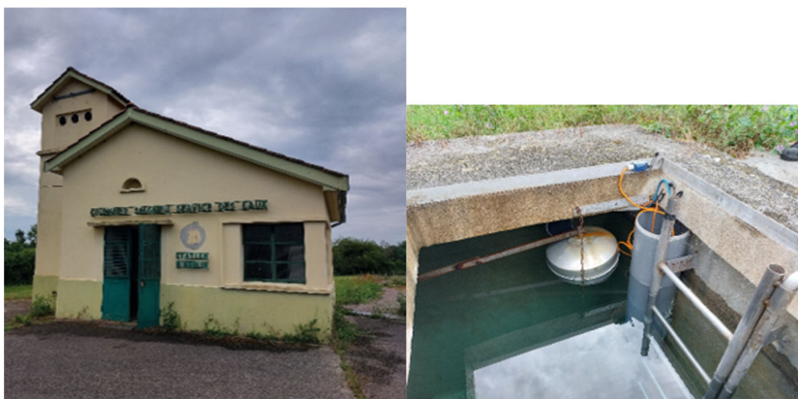
FIGURE 11 - PUIS STATION DE TRAITEMENT DU RECOLON AVEC BACHE DE MELANGE
