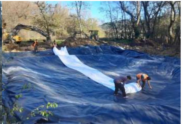
Pose des bâches
