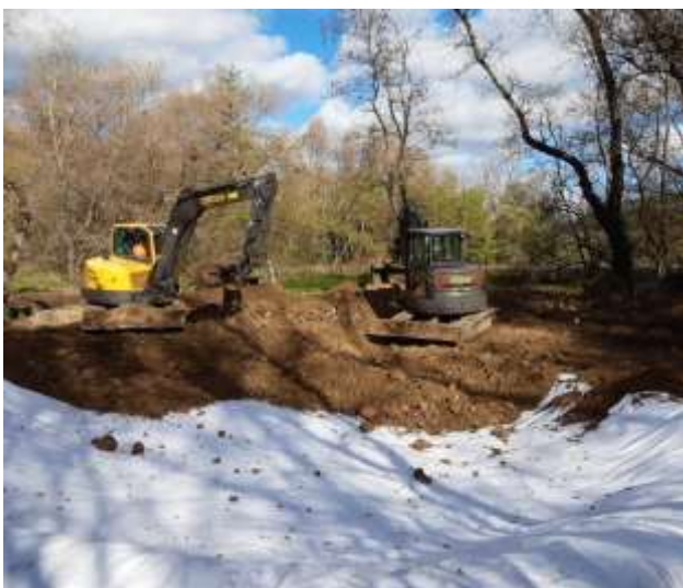
Remplissage avec terre/galets et profilage
