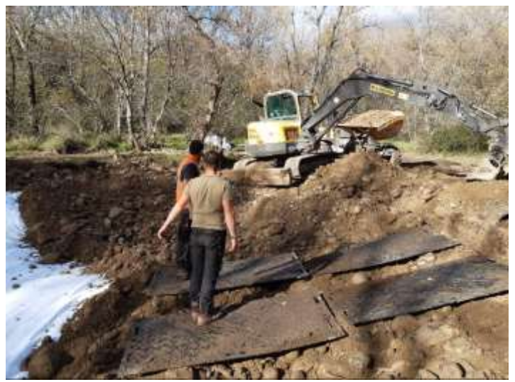
Remplissage avec terre/galets et profilage
