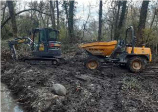
Evacuation des déblais
