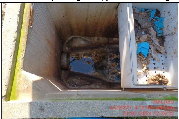
Conduite départ dégrilleur, panier de stockage
