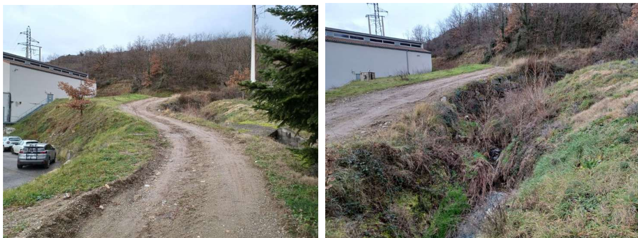
Figure 132 - Environnement du site / Accès en partie haute de l'usine – Ruisseau de rejet
