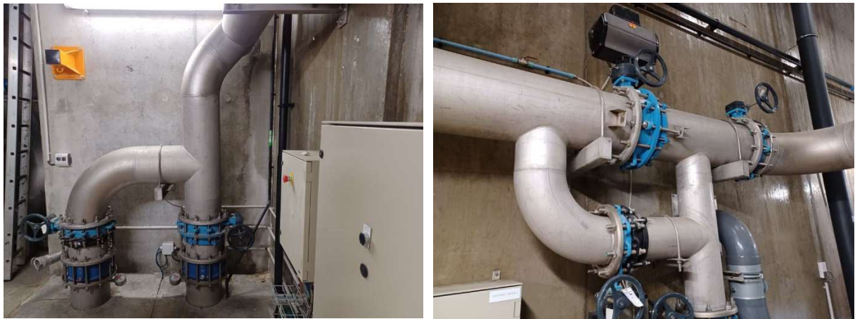
Figure 143 - Réseau eau de lavage des filtres
