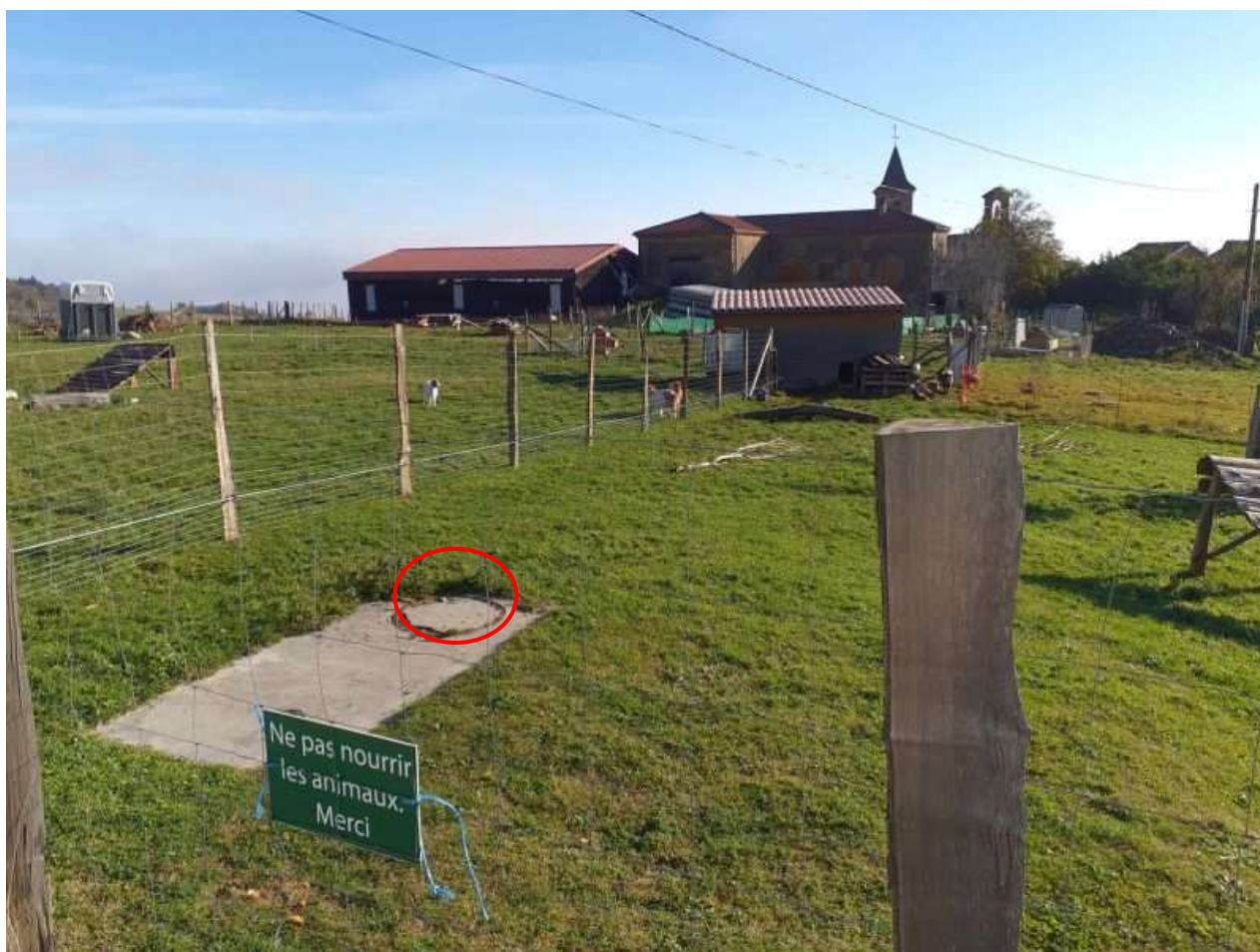
Figure 117 - Chambre d'un régulateur située sur la commune de Saint-Victor (Navas)
