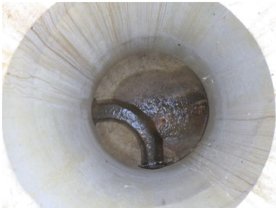
Infiltration - TP3 – Gorrevod – vue intérieure
