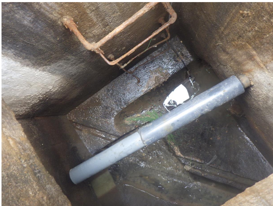
Modification du DO n°3 – Bâgé-le-Châtel – vue rapprochée
