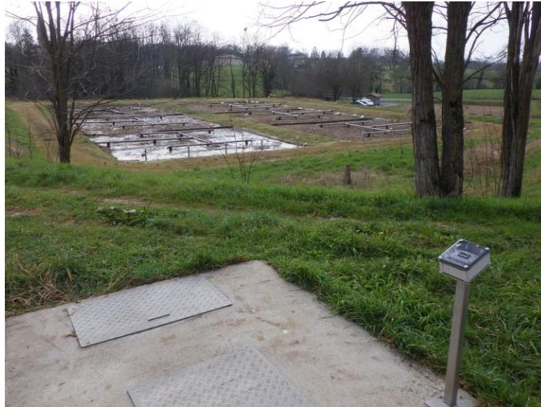
Vue du premier étage de filtres
