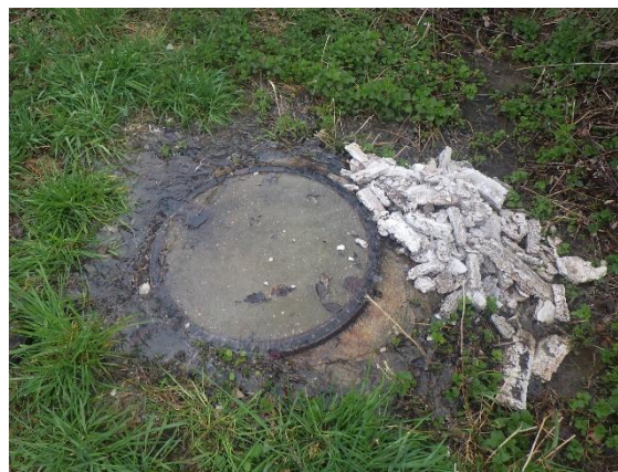
Mise en charge – Regard amont PR5 – Saint-Bénigne – vue extérieure
