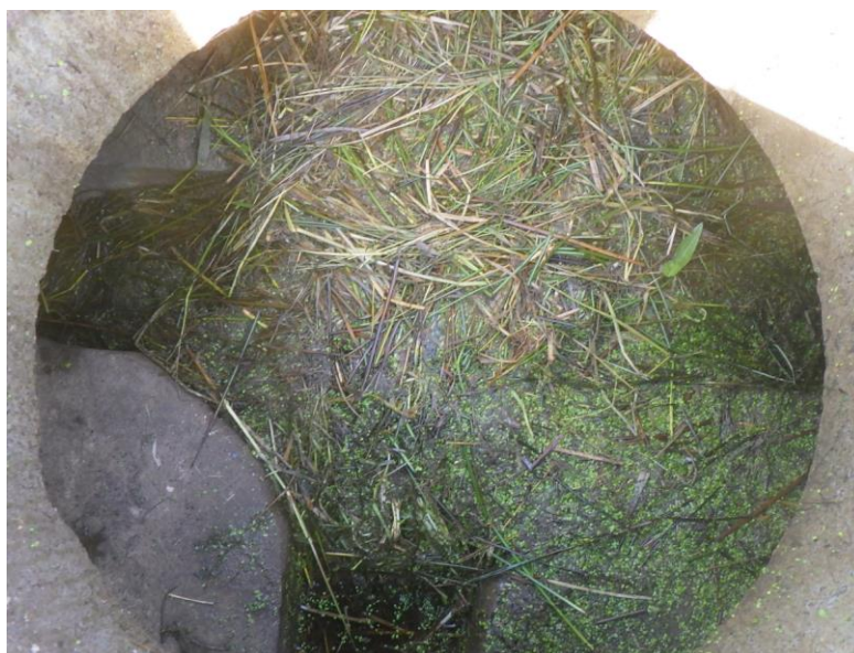
Vue intérieure du regard intermédiaire entre les 2 bassins de lagunage
