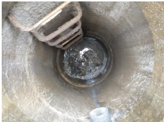
Dépôt – Regard n°102 – Bâgé-le-Châtel – vue intérieure
