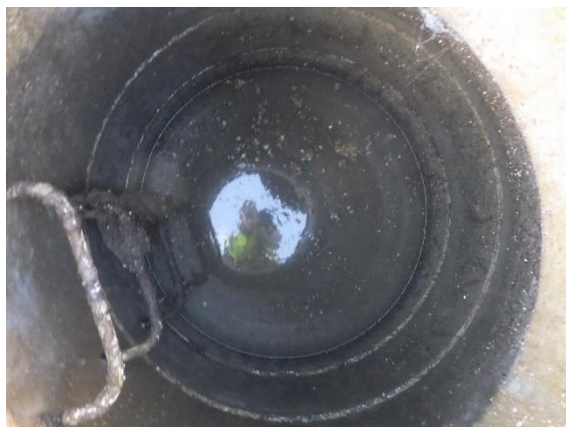
Mise en charge – Regard n°547 – Feillens – vue intérieure
