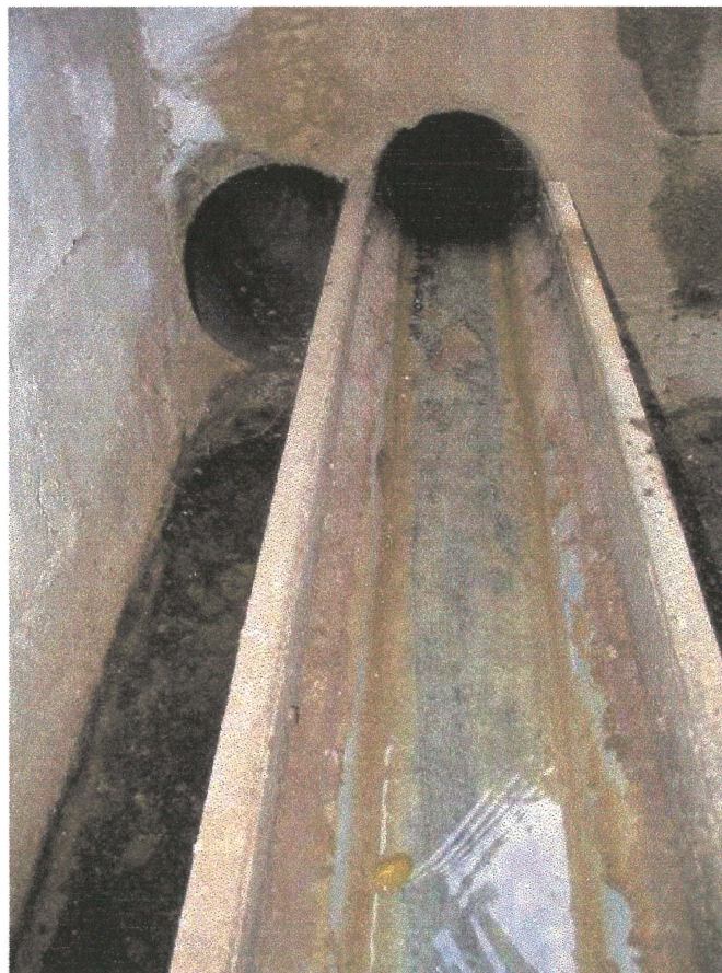
Fig. 3-c : Vue du DO3 : montée de la rue du Village, réseau séparatif
