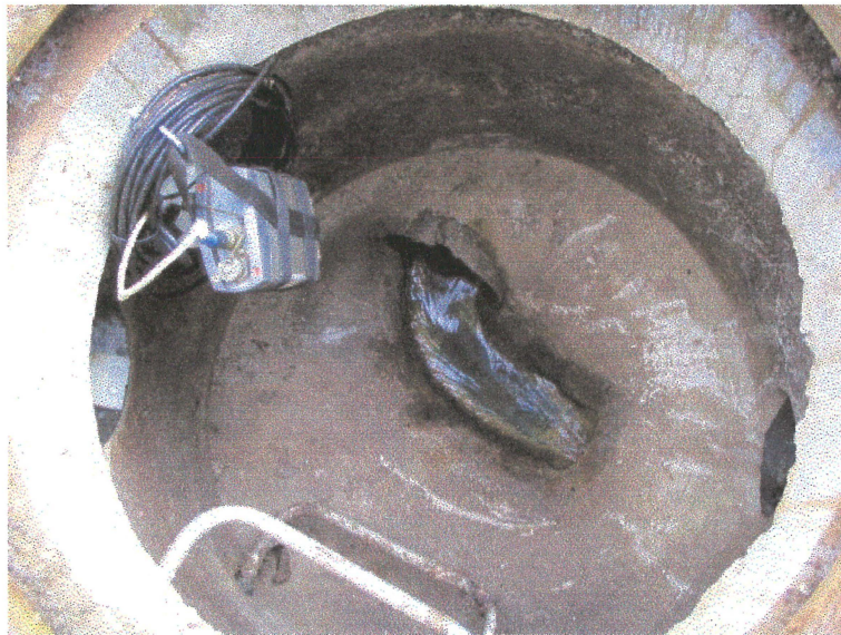
Fig. 3-b : Vue du DO 2 : bas du village de LAVEYRON, réseau séparatif
