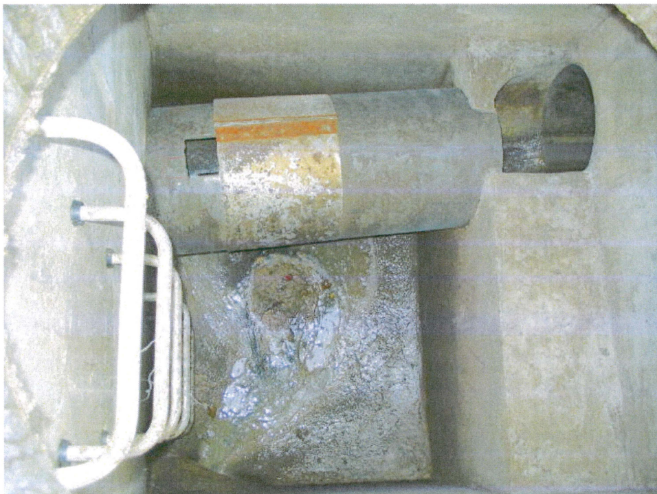
Fig. 2-d : le déversoir d'orage DO1
