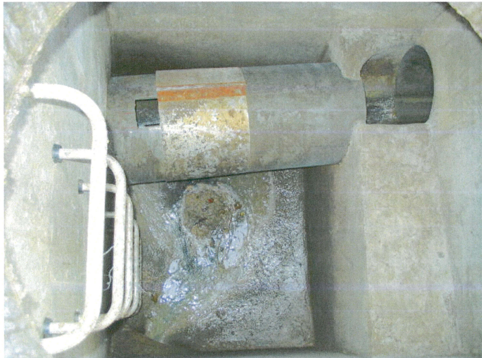
Fig. 4-a : le déversoir d'orage DO1
