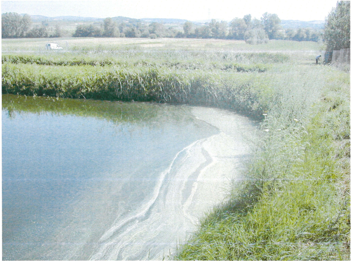
Photo : bassin de lagunage de VEAUNES – flottants en zone morte
