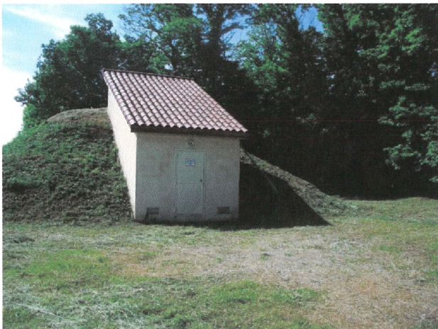
Accès au réservoir
