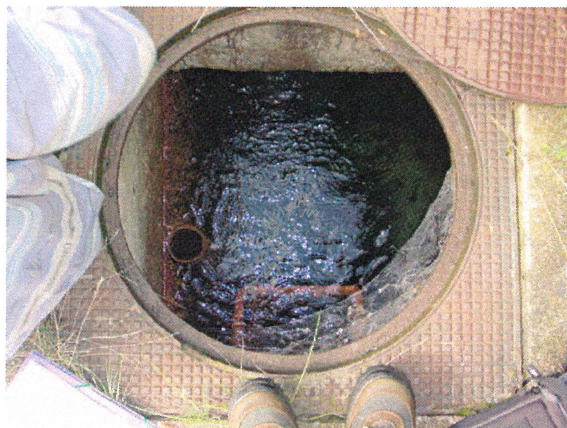
Vue de l'intérieur de la cuve
