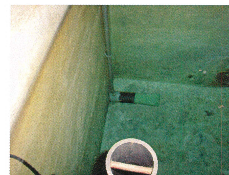
Vue de l'intérieur de la cuve
