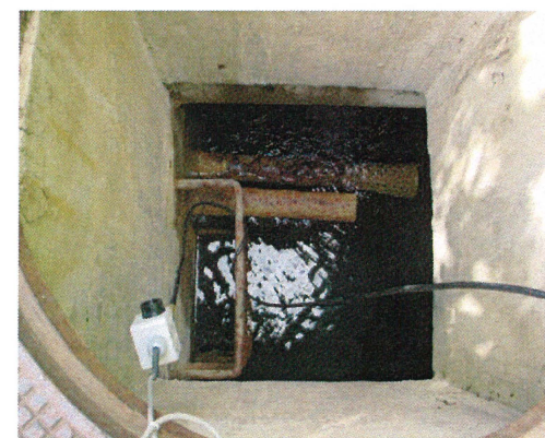
Vue de l'intérieur de la cuve
