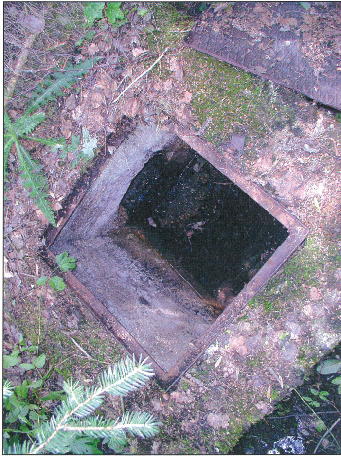
POINT D'EAU n°39 : Captage de L'Epine
