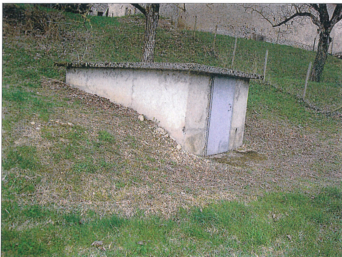
Vue de l'extérieur du regard de départ
