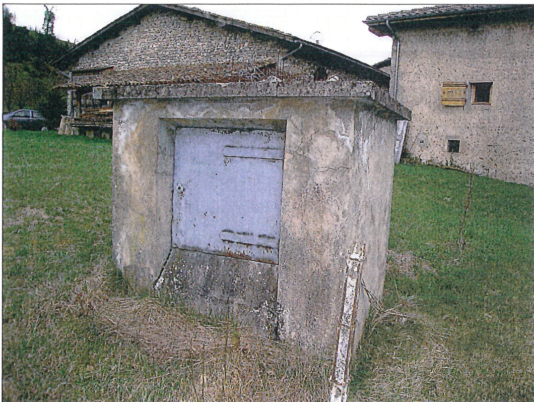
Vue de l'extérieur du regard de captage
