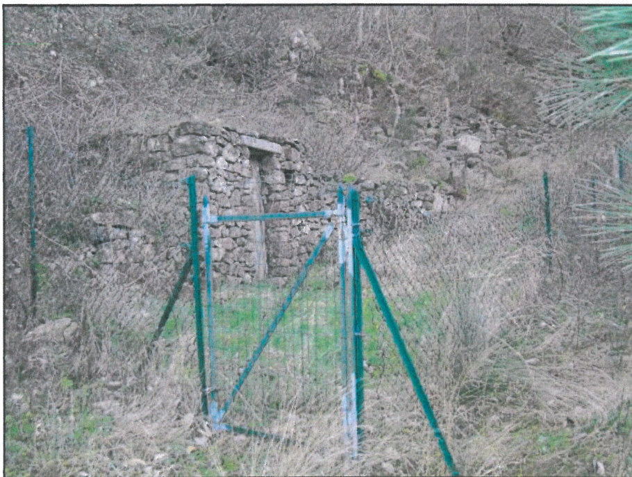
Source de La Mole - Périmètre de protection autour du captage - Novembre 2008
