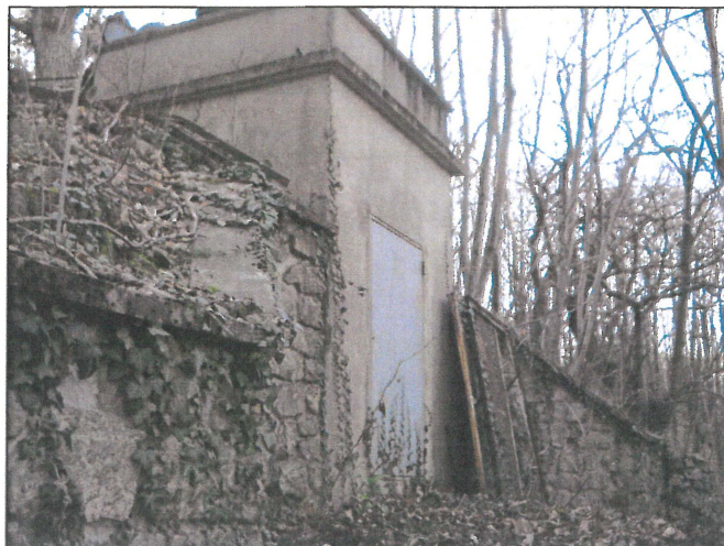
Réservoir de La Pervenche
