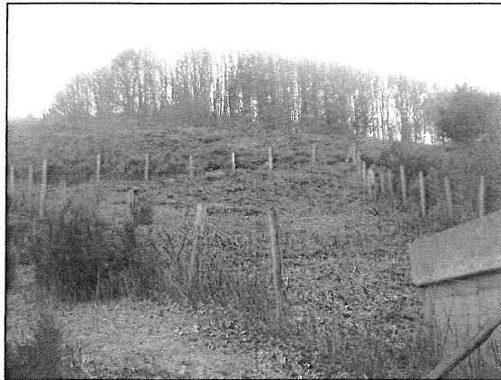
Extérieur du captage des Parjades
