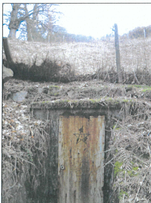
Extérieur du captage du Clos du Faux
