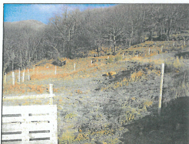
Extérieur du captage de Goutas
