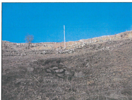
Extérieur du captage du Planas
