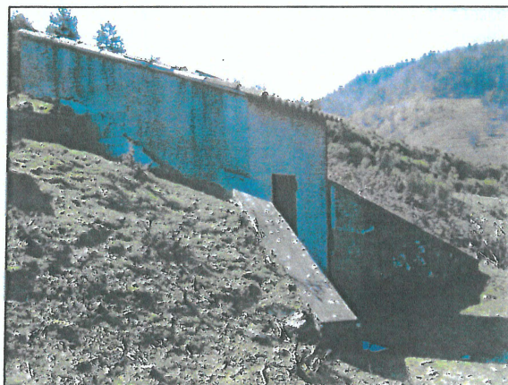
Réservoir du village
