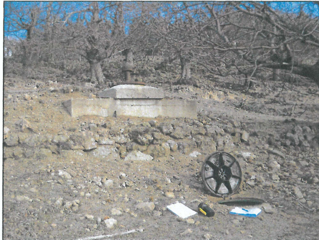
Réservoir de Charbonnière
