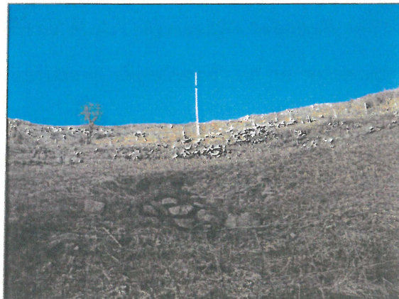
Extérieur du captage du Planas
