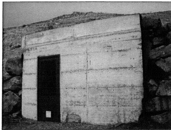
Extérieur du captage des Vergnes
