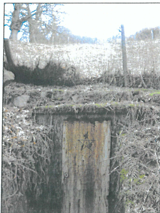
Extérieur du captage du Clos du Faux
