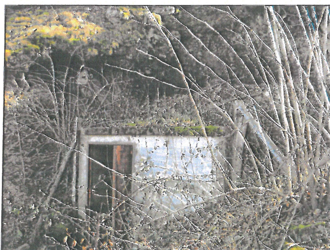
extérieur du captage de Fontbelle
