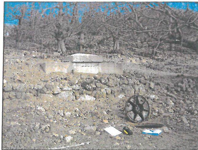
Réservoir de Charbonnière
