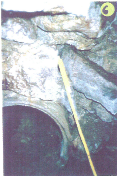
Canalisations Ø530 et Ø100 + mur écroulé à 56 m
