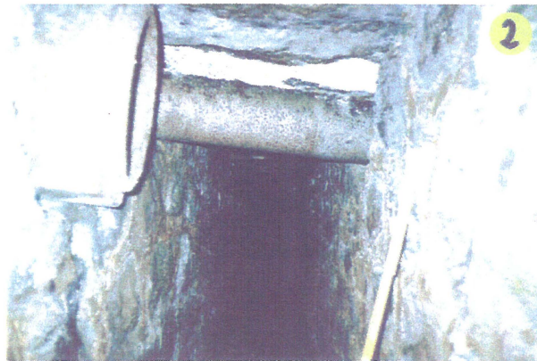
Canalisation pénétrante et traversante à 10.7 et 11.4 m
