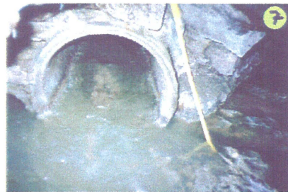
Canalisation pénétrante et traversante à 10.7 et 11.4 m
