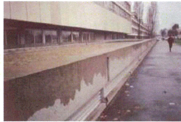
Aménagement en décroché de toiture-terrasse sur site hospitalier Source CETA du Sud-Ouest
