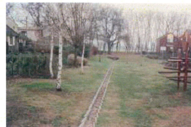
Noue et cunette en béton à Villaboiss Bruges (33) Source CETE du Sud-Ouest
