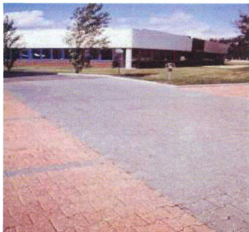
Parking réservoir et pavés drainants de la zone d'activité du Phare (33) Source CETE du Sud-Ouest
