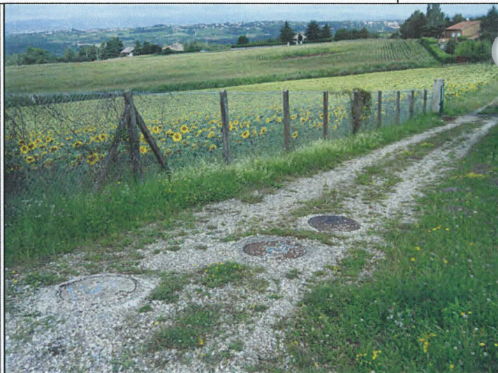
Vue extérieure des regards 2,3 et 4
