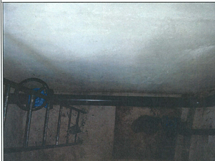
Réservoir 2 Alimentation + Vidange + Trop Plein
