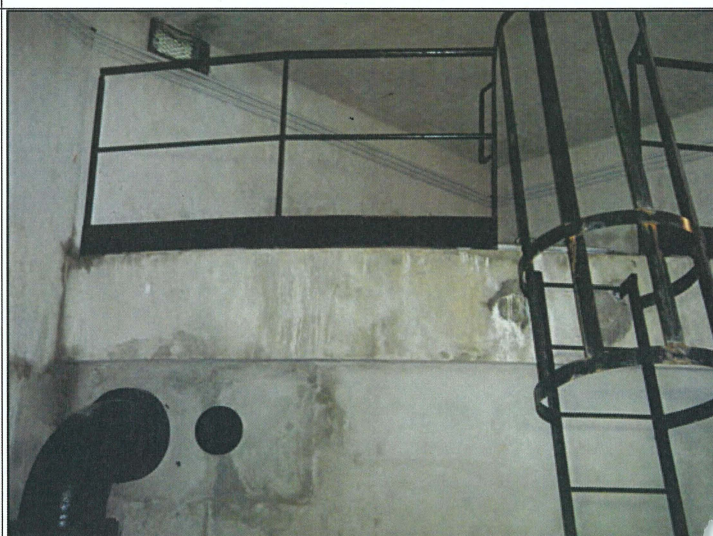
Réservoir 2 Chambre de vannes - Accès à la cuve
