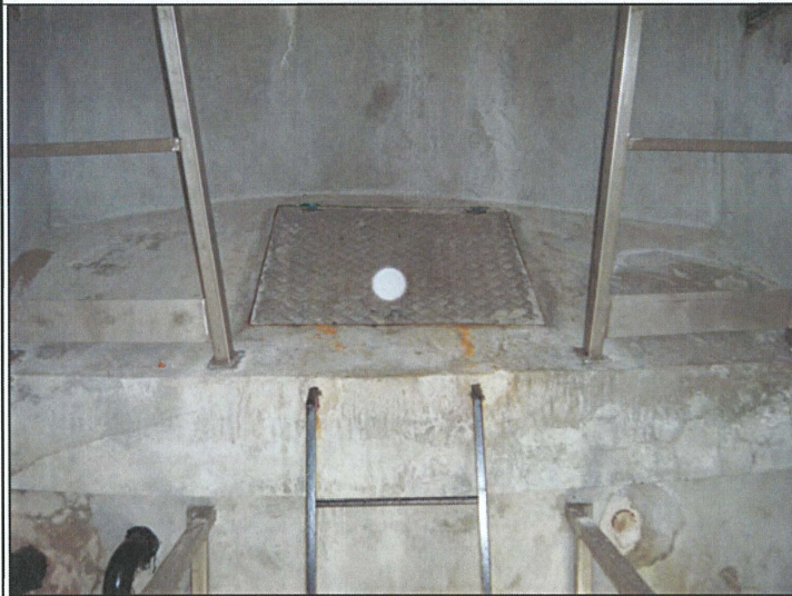
Réservoir 2 Accès cuve
