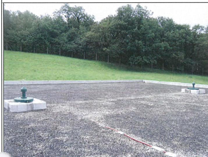
Réservoir 1 Vue extérieure de la cuve
