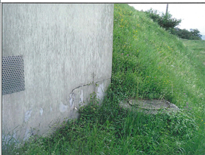
Regard 1 Evacuation trop plein et vidange du réservoir 1
