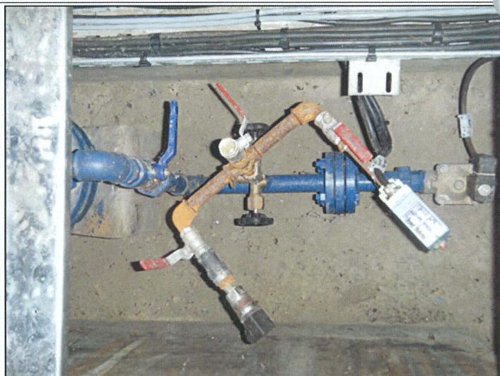
Pressostat et sonde de pression
