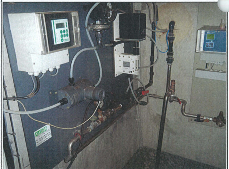
Système de Chloration
