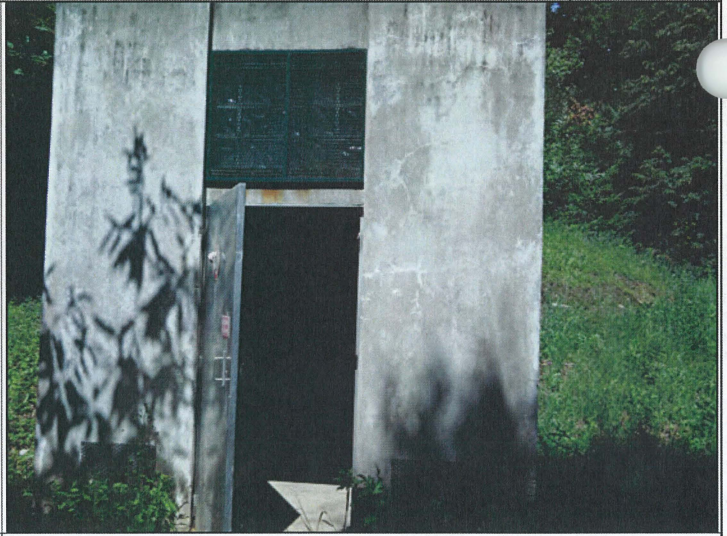
Vue extérieure Réservoir 2
