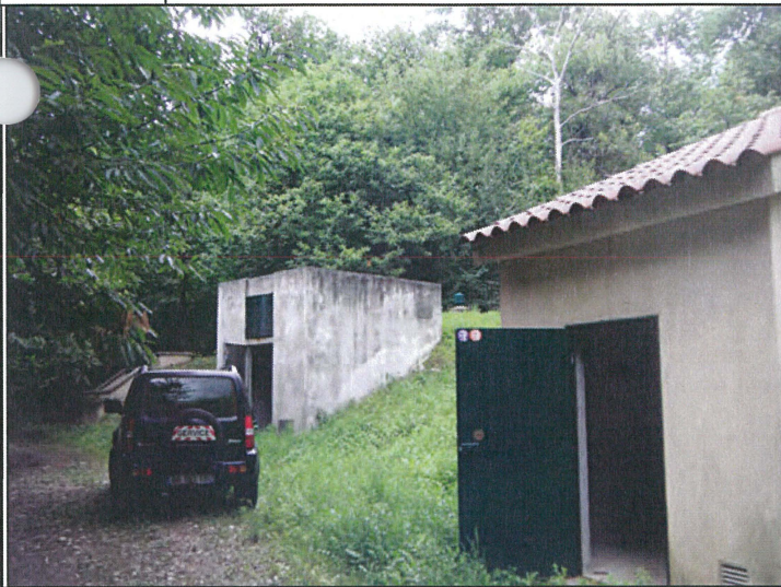
Vue extérieure des deux Réservoirs
