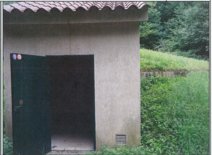
Vue extérieure Réservoir 1
