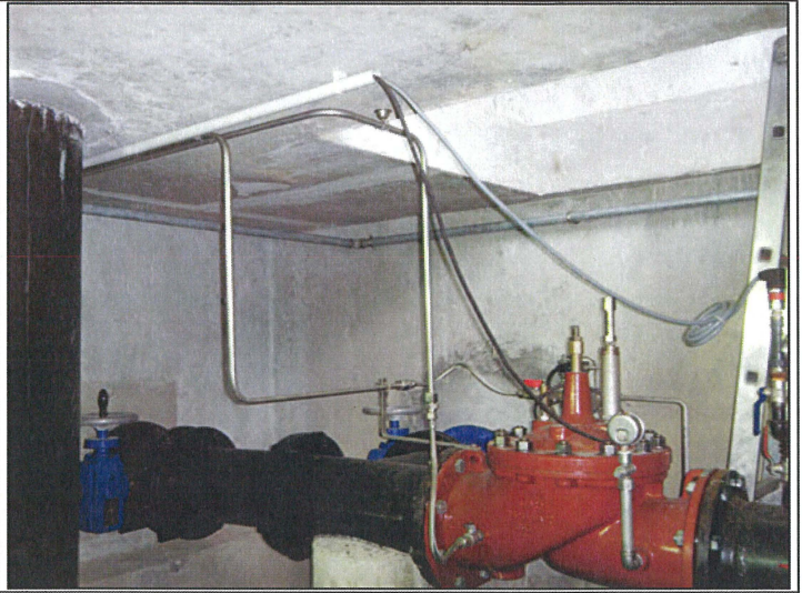
Chambre de vannes - Alimentation avec hydrostab
