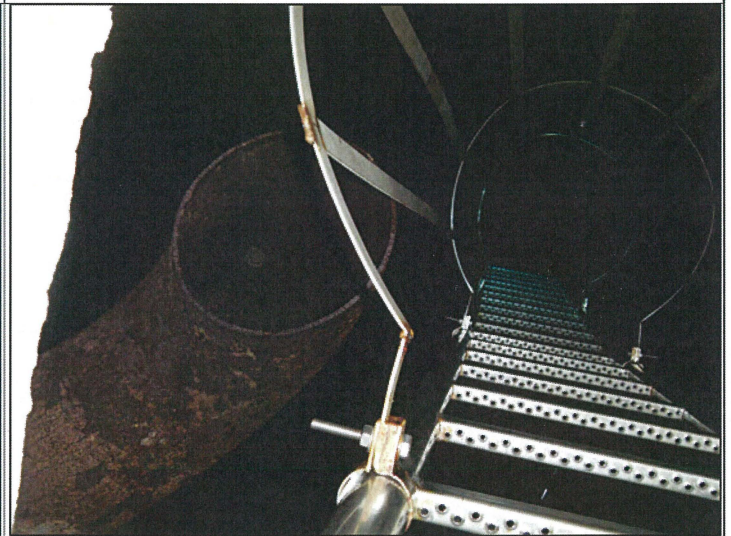
Réservoir 2 Accès cuve + Trop plein
