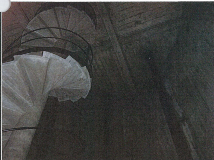
Accès Chambre de vannes
