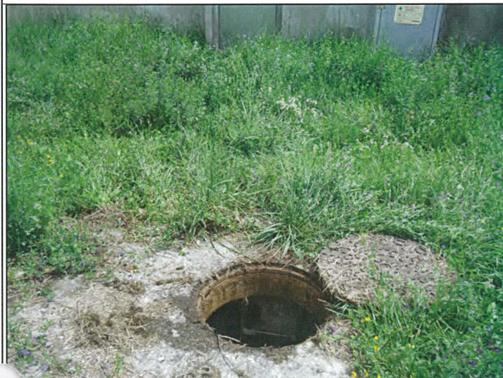
Vue extérieur Regard 5
