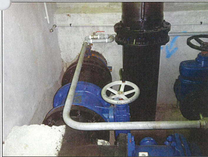
Chambres de vannes - Distribution et trop plein
