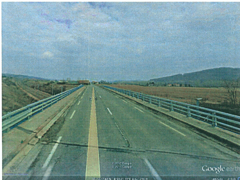
Franchissement de la D51 sur la voie TGV fortement encaissée
