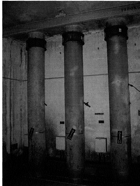
Figure 17 : Relevage des effluents
