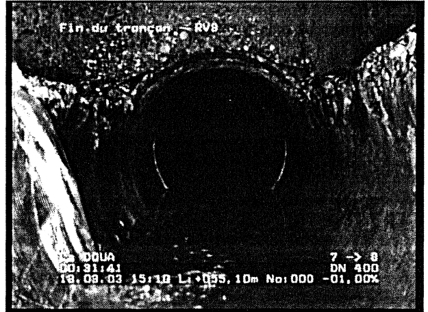
Photo: 5_3a, N° cassette: 1, 00:31:48 55,1m, Fin du tronçon - RV8 (9102)
