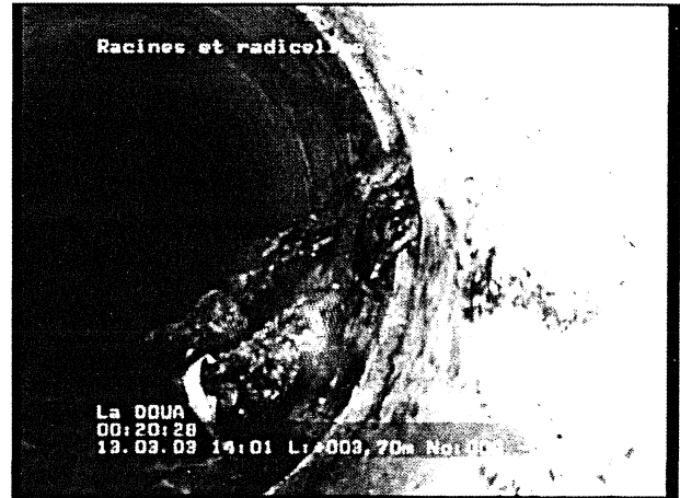
Photo: 4_3a, N° cassette: 1, 00:20:23 3,7m, Racines et radicelles à 04 h.
