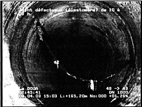
Photo: 27_10a, N° cassette: 1, 02:45:35 165,2m, Joint défectueux (élastomère) de 10 à 03 h.
