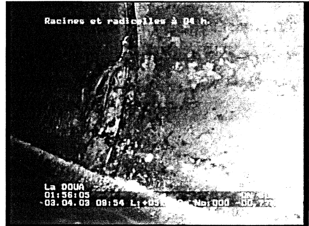
Photo: 19_7a, N° cassette: 1, 01:56:01 51,3m, Racines et radicelles à 04 h.
