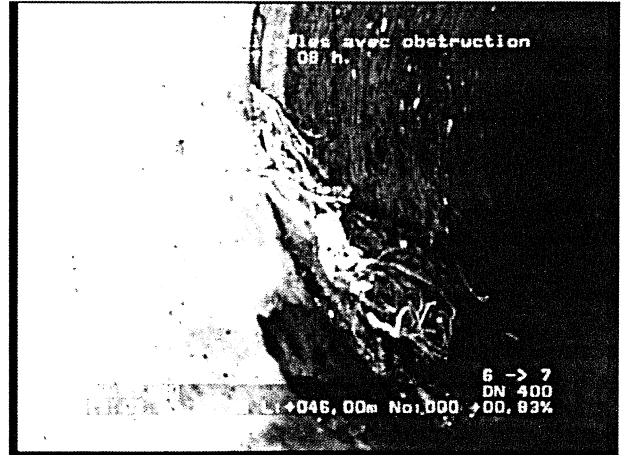
Photo: 4_15a, N° cassette: 1, 00:26:58 46m, Racines et radicelles avec obstruction partielle de 07 à 08 h.
