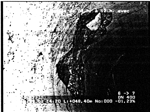
Photo: 4_16a, N° cassette: 1, 00:27:15 48,4m, Cassure déformée de 09 h. à 12 h. avec armatures visibles
