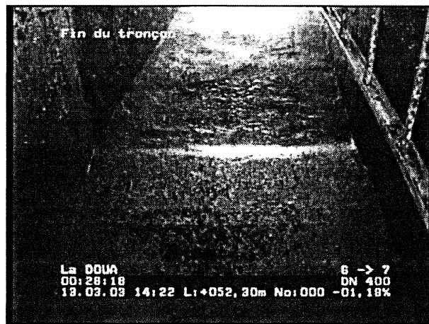
Photo: 4_19a, N° cassette: 1, 00:28:26 52,1m, Fin du tronçon - RV7 (1415)
