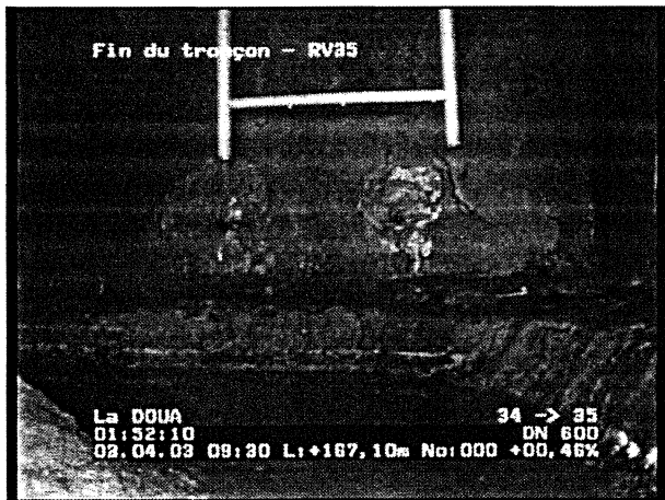
Photo: 18_8a, N° cassette: 1, 01:52:16 167,1m, Fin du tronçon - RV35 (30)
