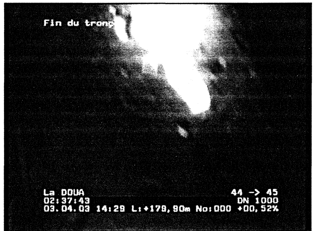
Photo: 26_17a, N° cassette: 1, 02:37:52 179,9m, Fin du tronçon - RV45 (4015)
