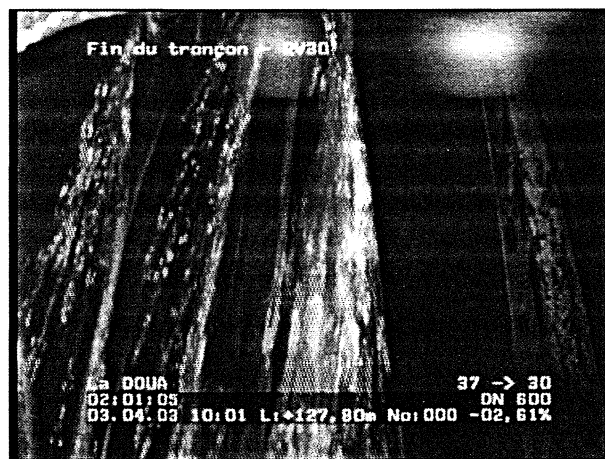
Photo: 19_13a, N° cassette: 1, 02:01:01 127,8m, Fin du tronçon - RV30 (25)
