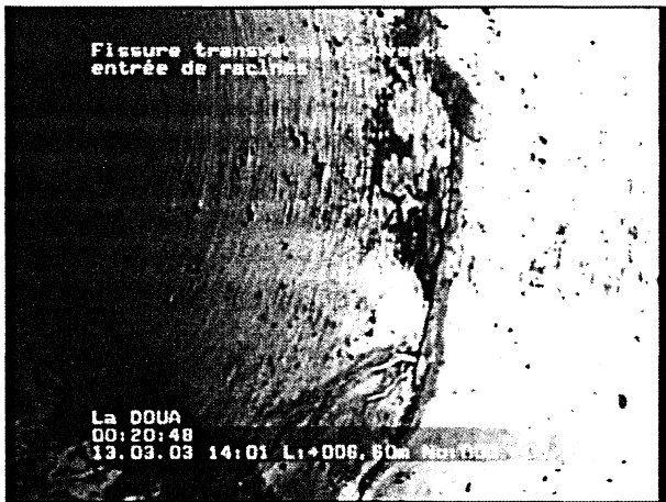
Photo: 4_4a, N° cassette: 1, 00:20:44 6,6m, Fissure transversale ouverte avec entrée de racines
