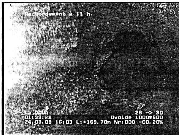
Photo: 17_8a, N° cassette: 1, 01:39:19 169,7m, Raccordement à 11 h.
