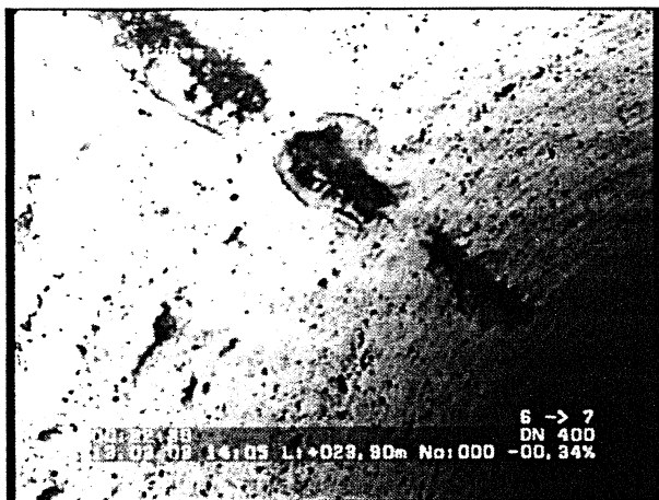
Photo: 4_8a, N° cassette: 1, 00:22:34 23,9m, Armatures visibles à 10 h.
