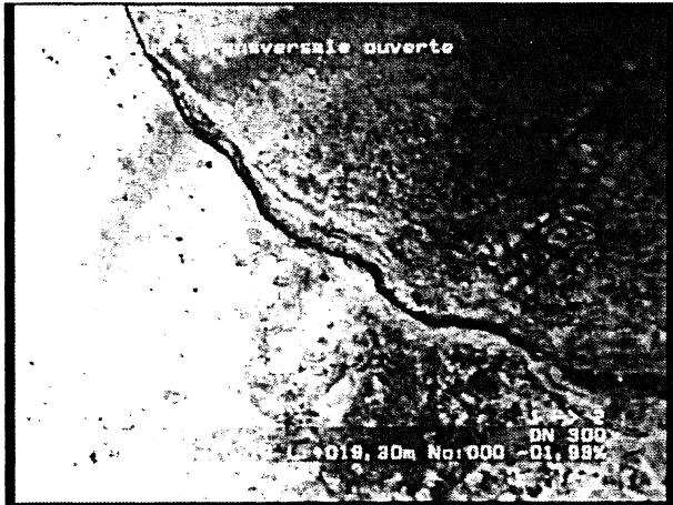
Photo: 1_6a, N° cassette: 1, 00:02:39 19,3m, Fissure transversale ouverte
