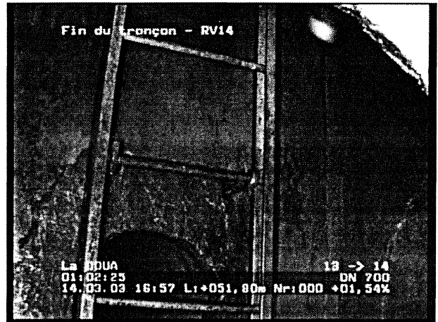
Photo: 11_11a, N° cassette: 1, 01:02:44 51,8m, Fin du tronçon - RV14 (1030)
