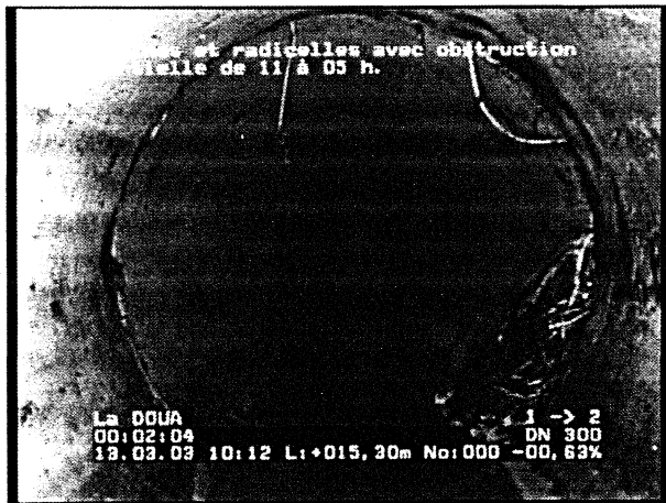
Photo: 1_4a, N° cassette: 1, 00:02:03 15,3m, Racines et radicelles avec obstruction partielle de 11 à 05 h.
