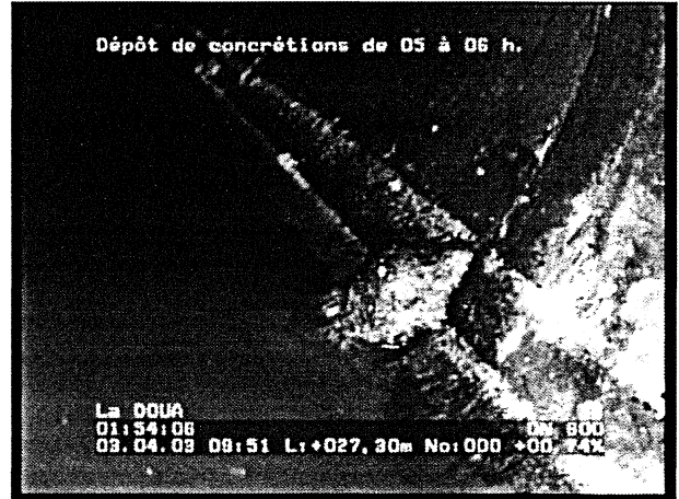
Photo: 19_3a, N° cassette: 1, 01:54:02 27,3m, Dépôt de concrétions de 05 à 06 h.
