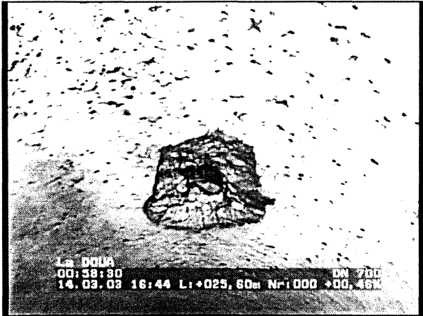
Photo: 11_6a, N° cassette: 1, 00:58:27 25,6m, Perforation à 12 h.
