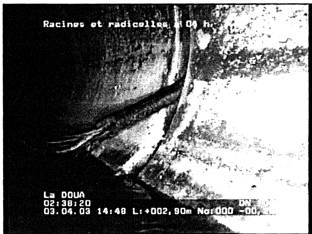
Photo: 27_2a, N° cassette: 1, 02:38:15 2,9m, Racines et radicelles à 04 h.
