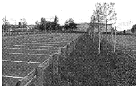
Parking avec un espace d'infiltration central, Neydens
