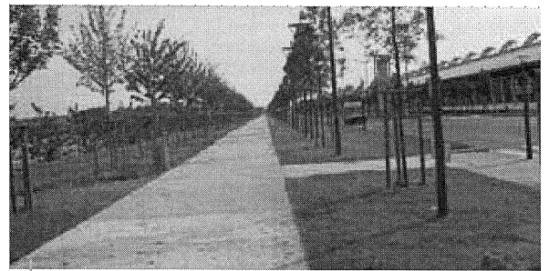
Cheminement en béton poreux
