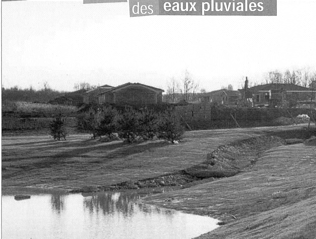
Bassin en eau « jardin des quincias », Villefontaine
