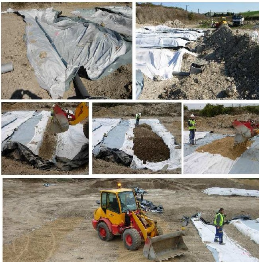
Illustration 7 : Travaux de réalisation des plots
