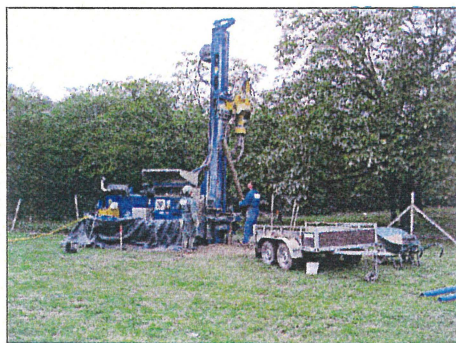
Création d'un piézomètre et retrait d'une pompe immergée
