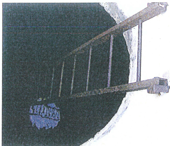
Echelle immergée à changer
