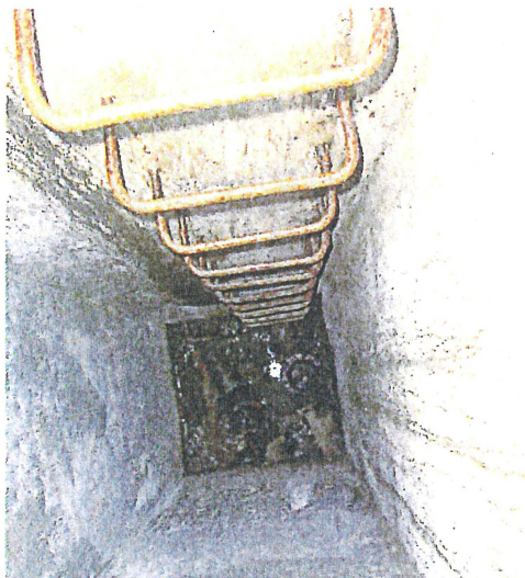
Ouvrage 4 – passerelle à changer
