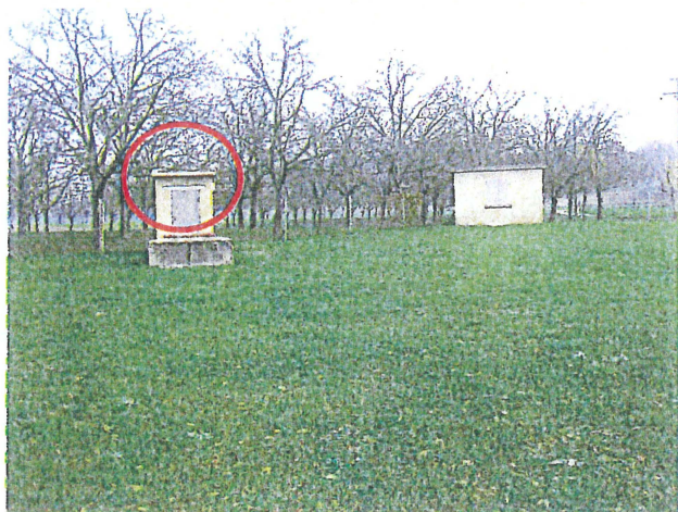
Ouvrage 3 – vue extérieure
