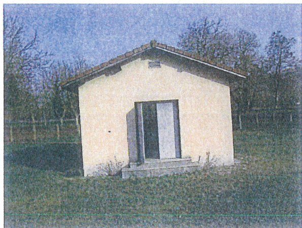
Vue extérieure de la chambre de vannes
