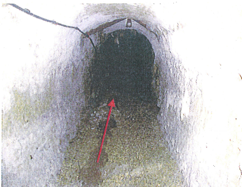
Entrée tunnel de La Poype Eaux canalisées
