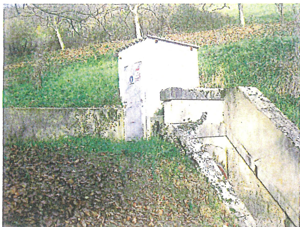
Sortie tunnel – vue extérieure
