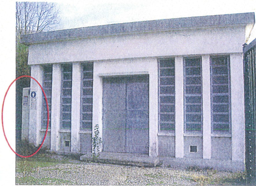
Vue extérieure Porte d'accès + local chlore gazeux
