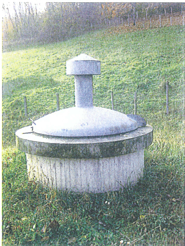
Capot d'accès à la cuve en acier galvanisé
