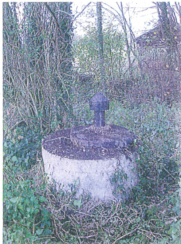
Ouvrage 1 – vue extérieure
