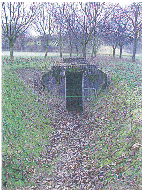
Entrée tunnel – vue extérieure
