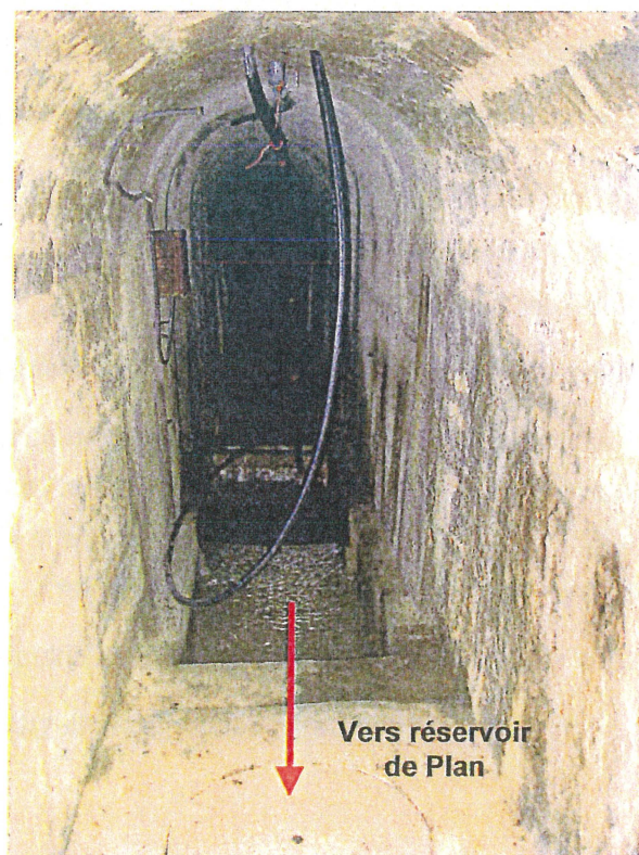
Sortie tunnel – vue intérieure
