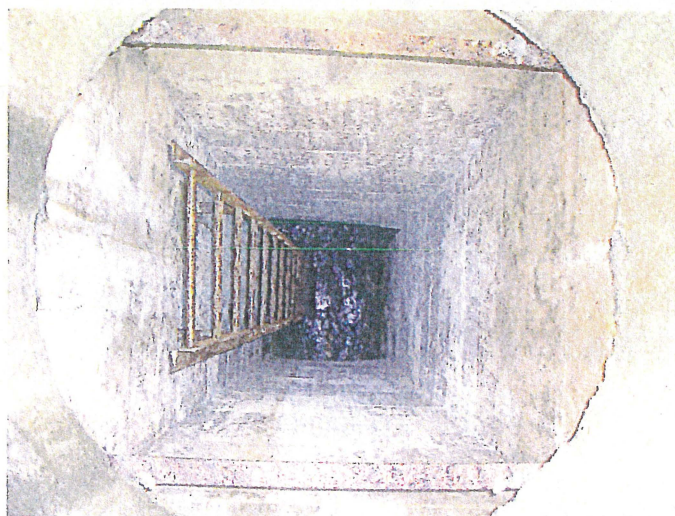
Ouvrage 1 – vue intérieure
