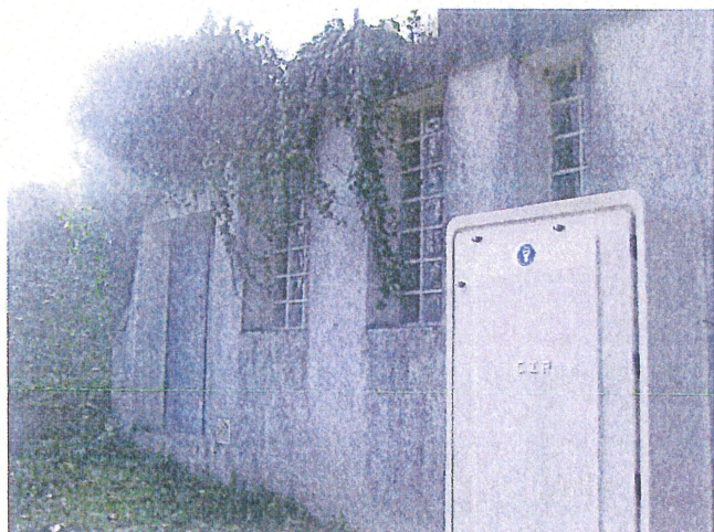
Vue extérieure Porte d'accès + local chlore gazeux
