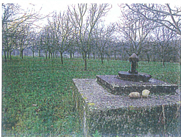
Ouvrage 2 – vue extérieure
