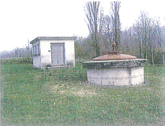
Accès chambre de vannes et puits
