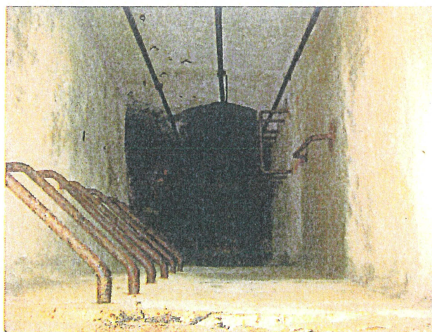
Ouvrage 3 – arrivée de la galerie Ouvrage de répartition
