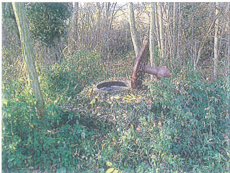
Ouvrage 2 – vue extérieure
