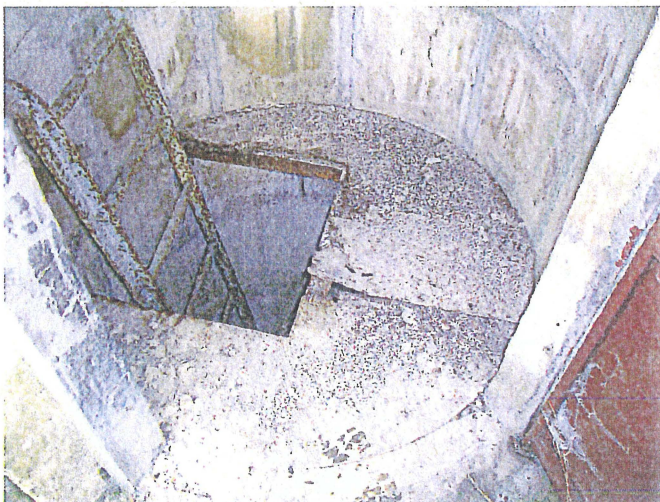
Ouvrage 4 – passerelle à changer
