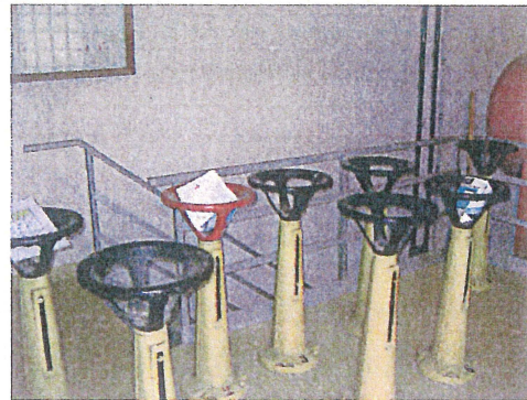
Volants de manœuvre des vannes papillons
