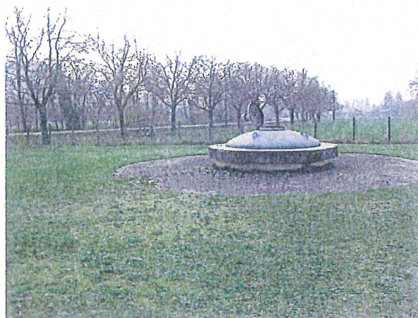
Accès au puits
