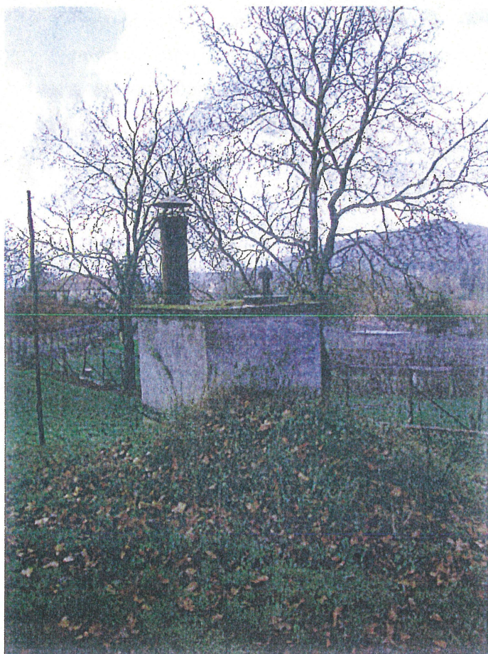
Entrée tunnel – vue extérieure
