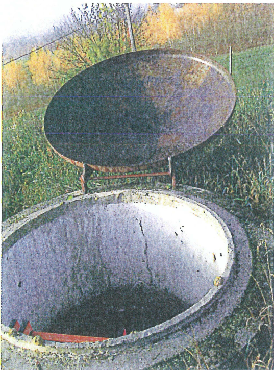
Capot d'accès à la cuve en acier
