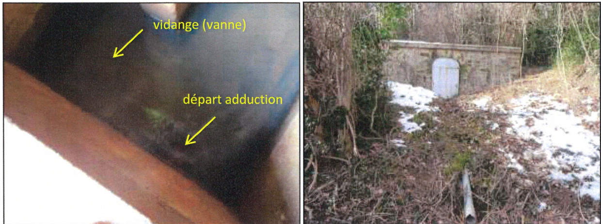
Figure 9 : vidange et départ du tuyau d'adduction
