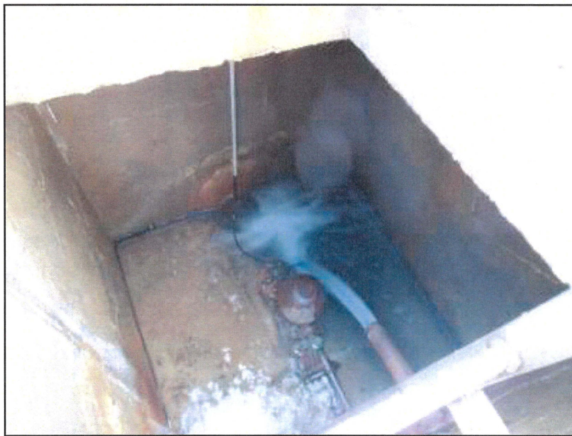
Figure 10 : chambre de distribution
