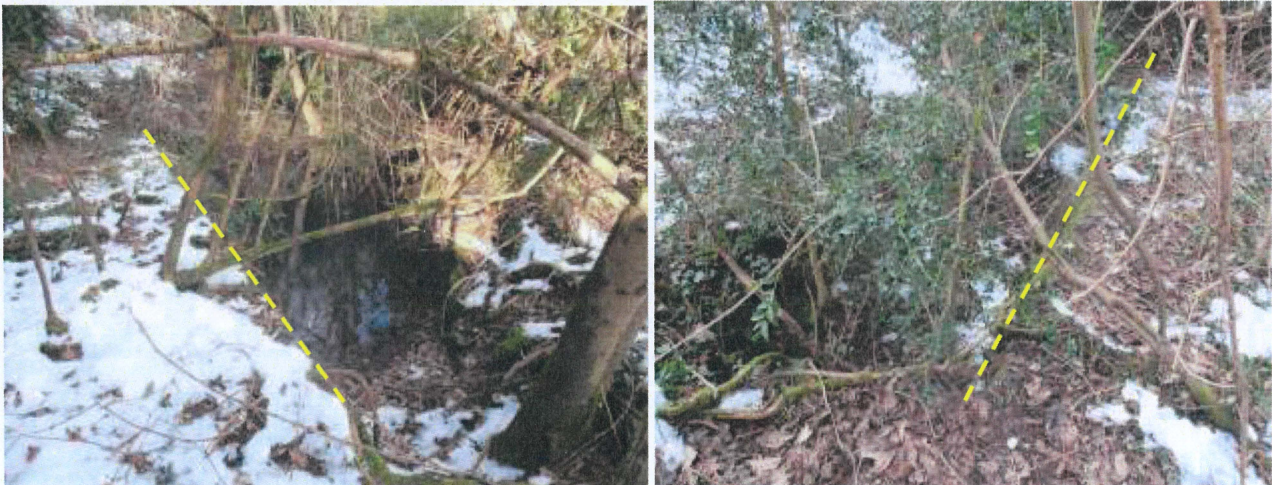
Figure 3 : murs de soutènement de la zone de drainage du captage de la source de BAVAS
