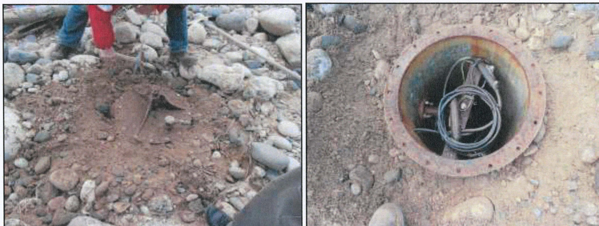
Figure 4 : le puits P2
