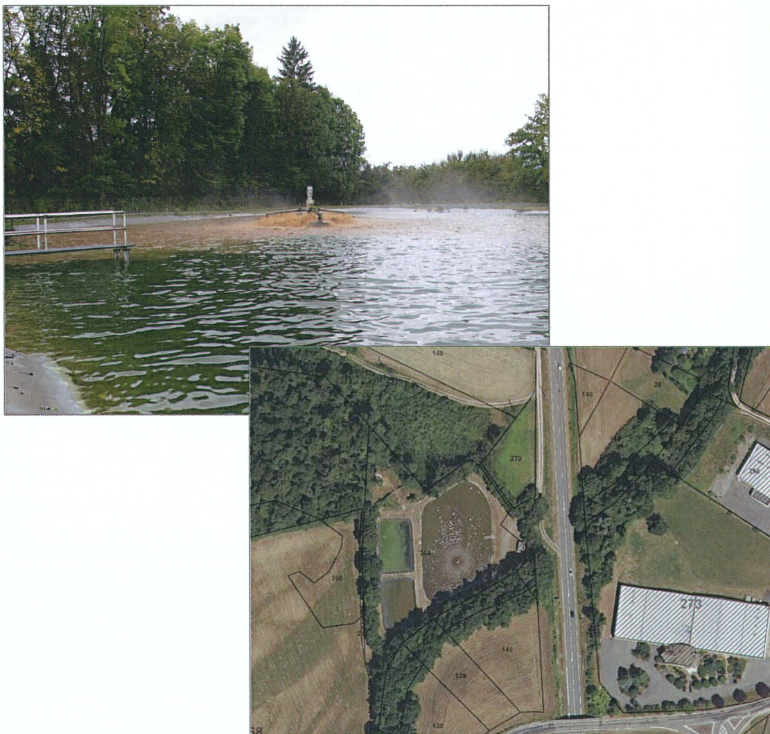
Photo de l'ouvrage avec aération en marche.
