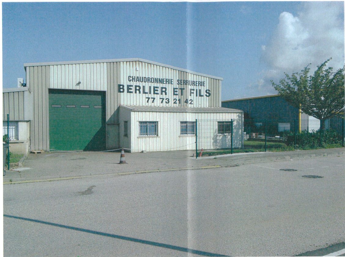
F2 - Inondation au niveau du local électrique de l'entreprise (PJAR-D5)
