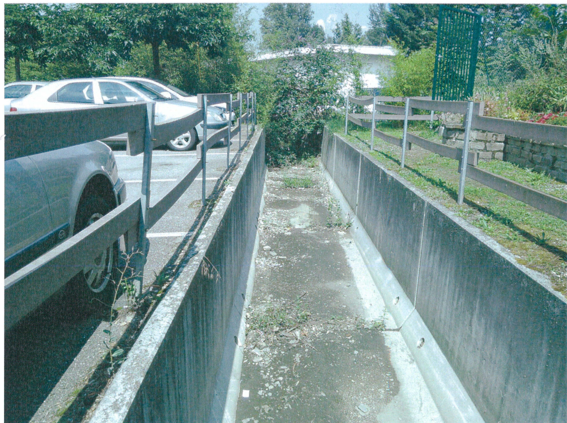
F7 - Inondation de la poterie en arrière plan (CHAT-D2)
