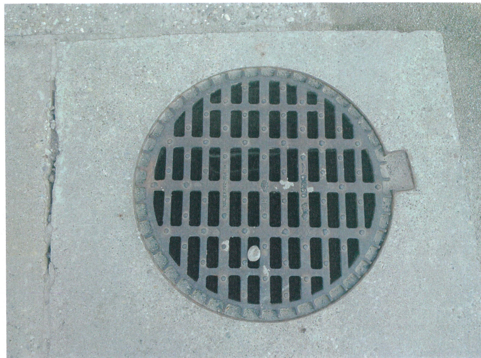
A1 - L'Onzion canalisé
